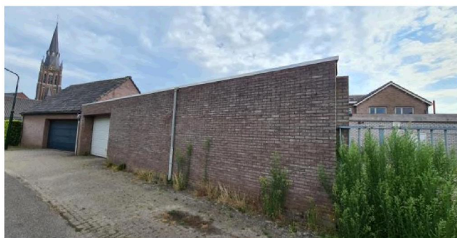
Figuur 7: Uitbouw gezien vanaf de Donksestraat
