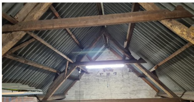
Figuur 8: Ruimte boven noordelijke koelcel
