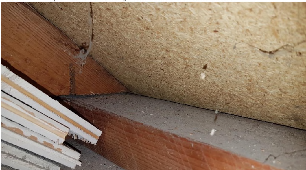
Foto 7. Vrijwel naadloze aansluiting tussen dakbeschot en dakconstructie
