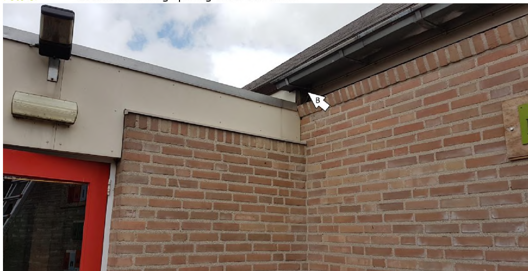
Foto 5. Locatieaanduiding opening onder dakrand B
