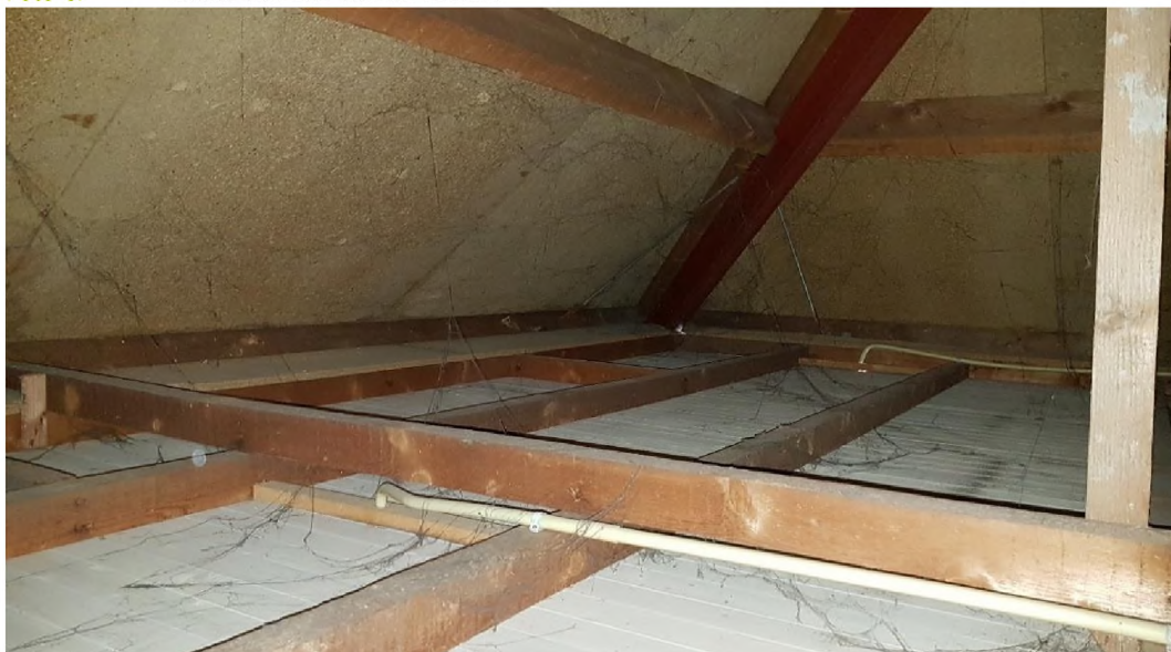
Foto 6. Beeld van één van de zolders
