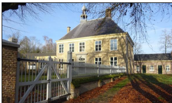
Het hoofdhuys gezien vanuit de tuin. Links de tuinmuur op de grens met het voorplein.
