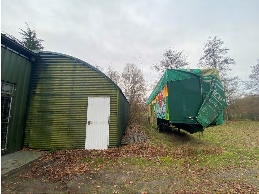
Figuur 10. Beeld van garage aan de achterzijde met een geparkeerde trailer.
