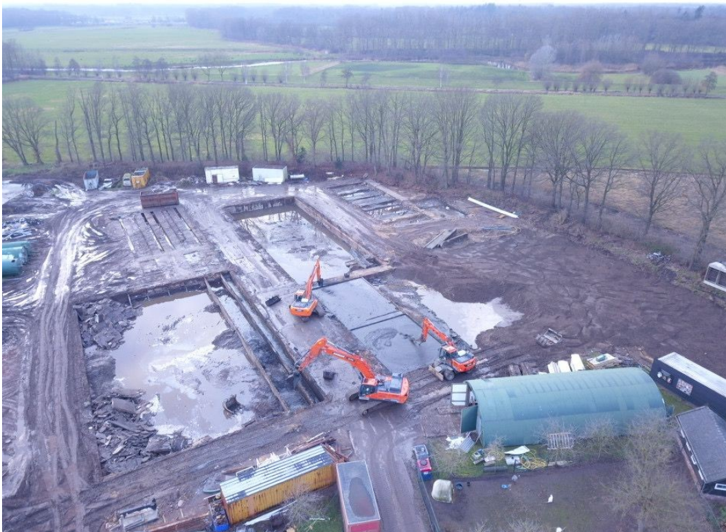
Figuur 6: Luchtfoto met overzicht van de saneringswerkzaamheden.
