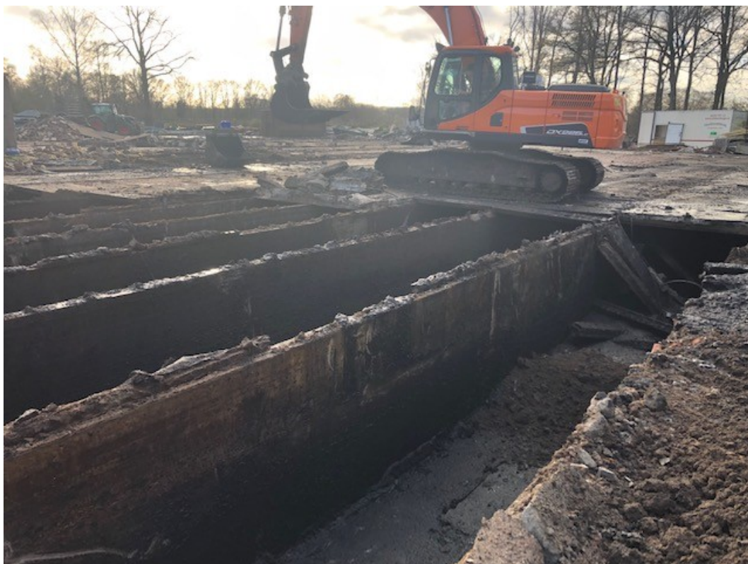
Figuur 4: Foto genomen tijdens sanering van de varkensstallen.
