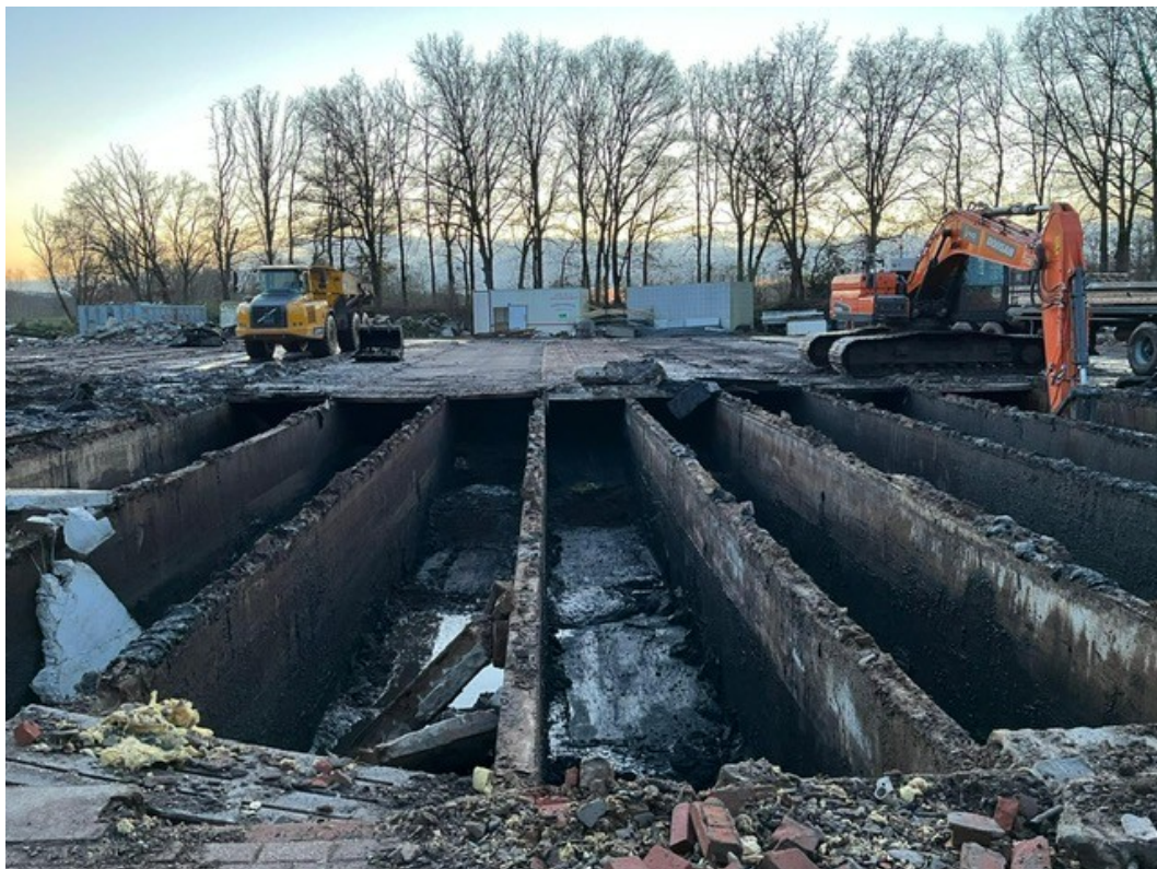
Figuur 5: Foto genomen tijdens sanering van de varkensstallen.
