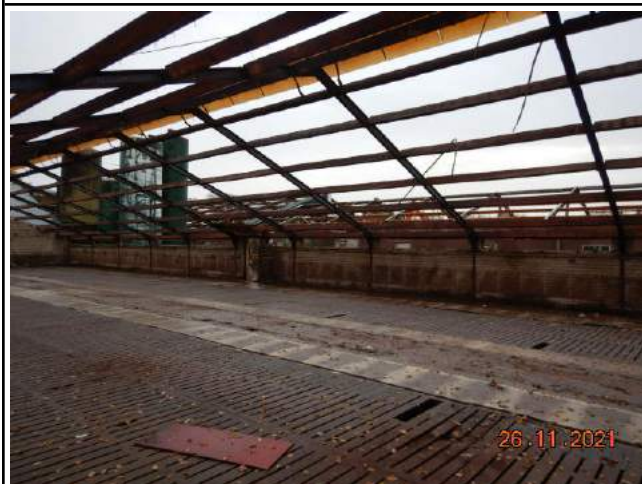
Foto 14. Mestputten, in de mestputten is alles uitgesloten van deze inspectie.
