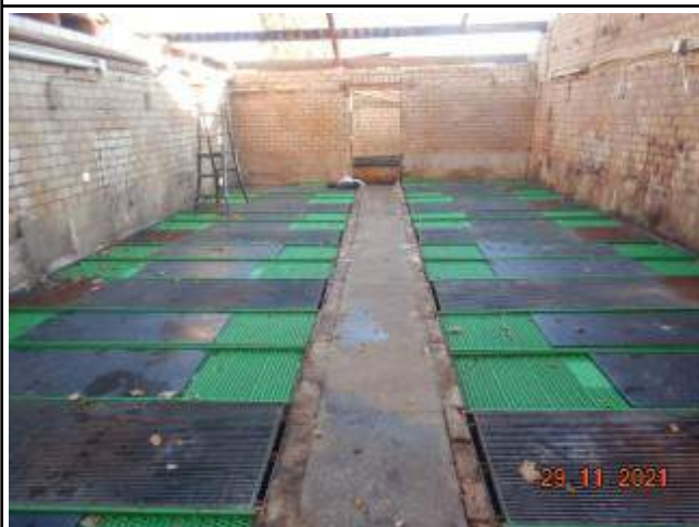
Foto 21: Vloer en mestputten.
