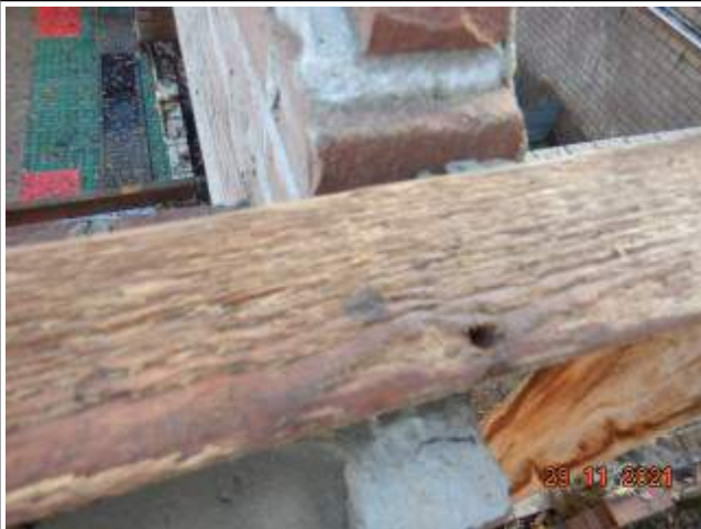
Foto 26: Na de aanvullende schoonmaak.
