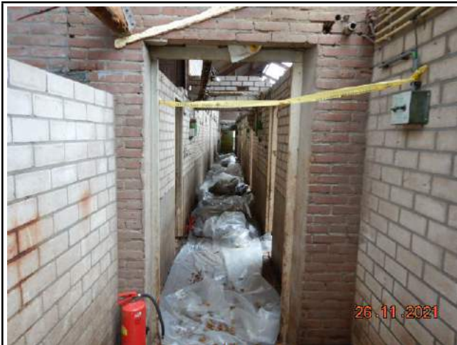
Foto 13. Asbestlint geplaatst naar stal 2 voor fase 2.
