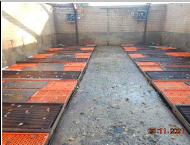
Foto 22: Vloer en mestputten.
