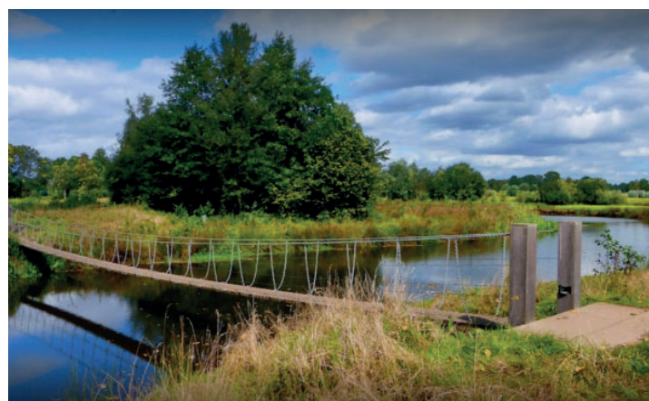
Hangbrug Essche stroomdal
