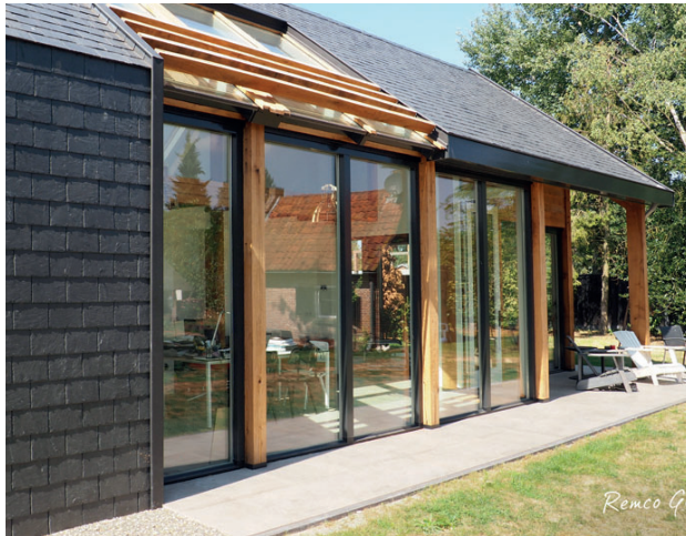
Horizontale geleding en overstek
