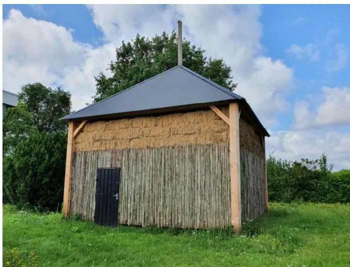
Recent gebouwde hooimijt
