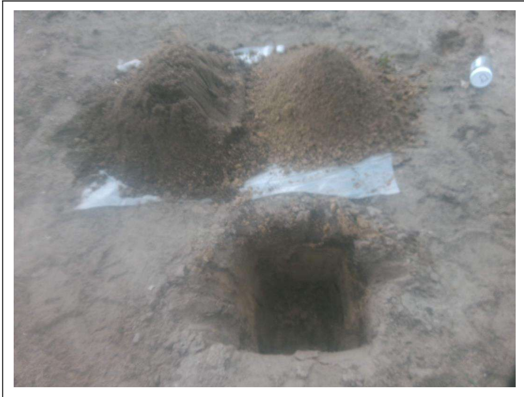
Foto asbestgat B03.
