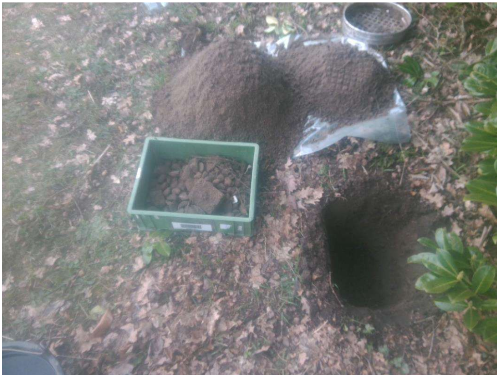
Foto asbestgat B01.
