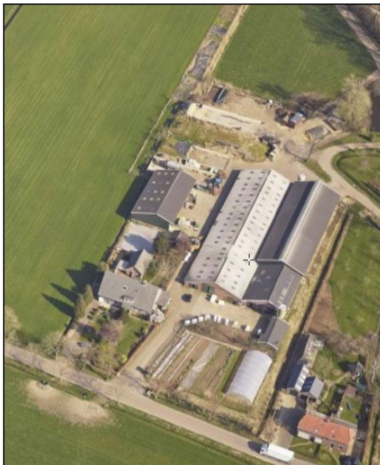
Luchtfoto bedrijfslocatie aan de Hooionkstraat 1b te Den Dungen
