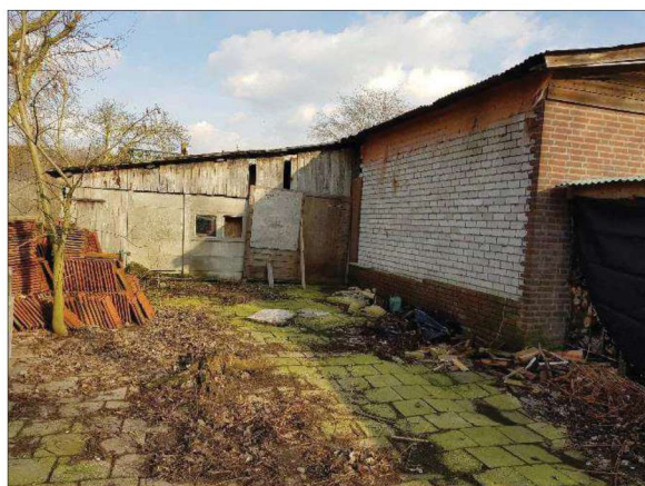
Figuur 9. Aanbouw noordzijde schuur
