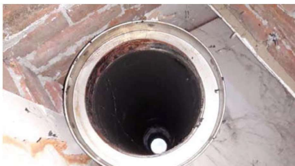
Buis in rookkanaal niet asbestverdacht
