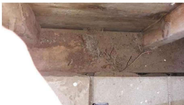
Houten afdekplaat spouwmuur
