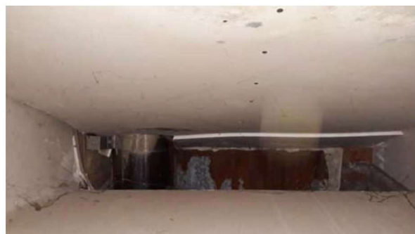
Gips beplating boven rookkanaal
