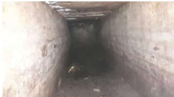
Smeerput niet asbestverdacht
