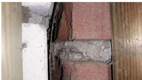
Spouwmuur niet asbestverdacht
