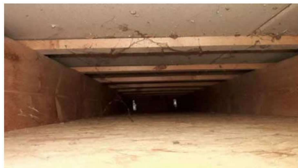
Boven aftimmering plafond, niet asbestverdacht
