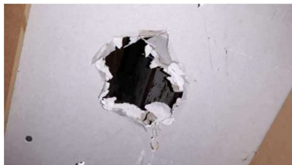
Niets asbestverdachts aangetroffen achter gipsplaten
