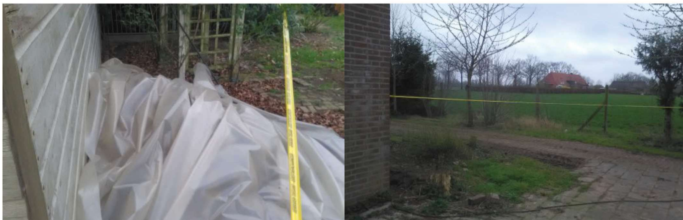
toelichting foto: vloer gedeeltelijk afgedekt met folie
