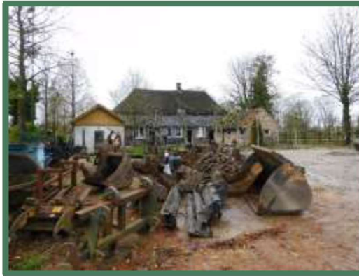
Achterzijde woning met bijgebouwen en opslag
