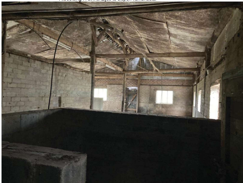
• Afbeelding 7: binnenzijde te slopen varkensstal
