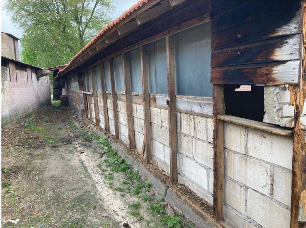
• Afbeelding 12: buitenzijde te slopen stal zonder spouwmuur
