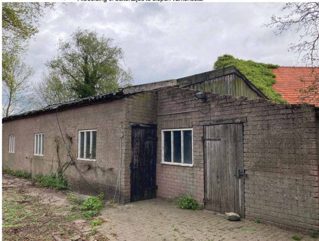
• Afbeelding 6: buitenzijde te slopen varkensstal
