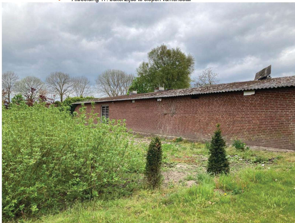
• Afbeelding 17: buitenzijde te slopen varkensstal
