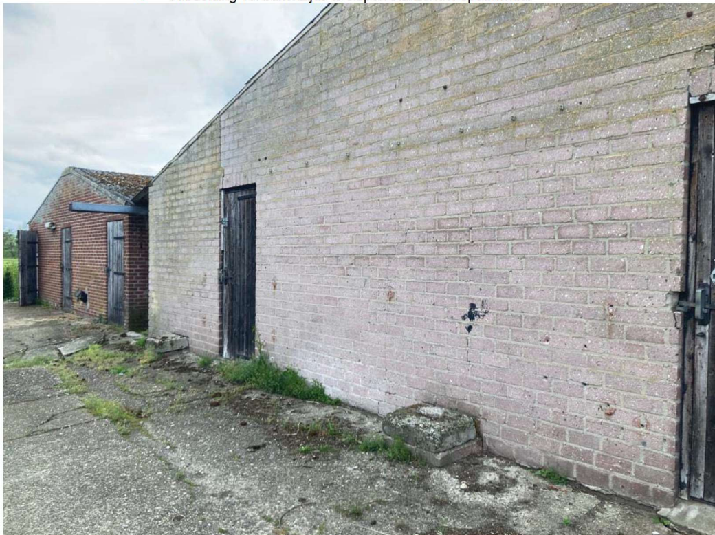
• Afbeelding 13: buitenzijde te slopen stal zonder spouwmuur
