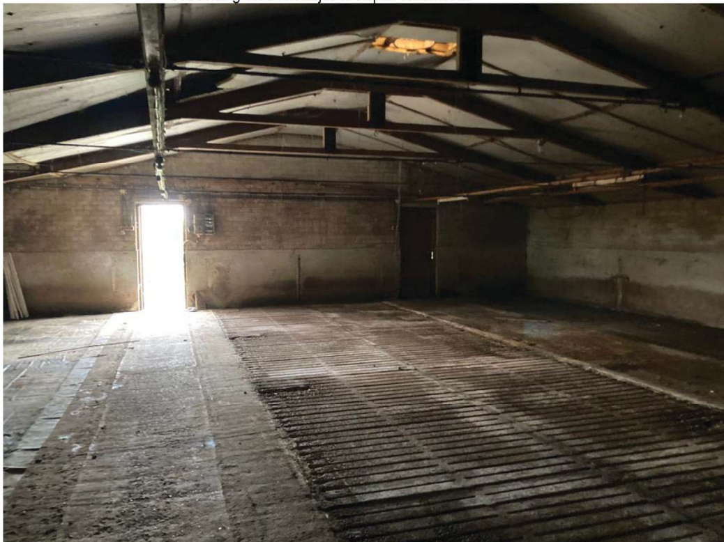
• Afbeelding 15: binnenzijde te slopen varkensstal
