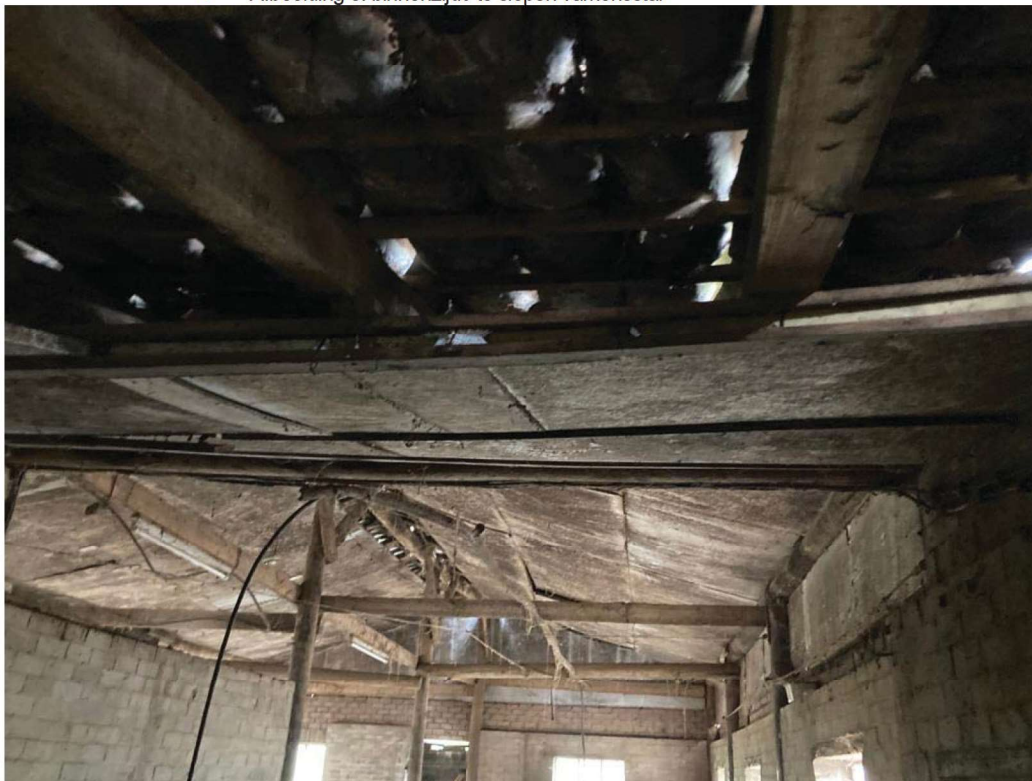
• Afbeelding 8: binnenzijde te slopen varkensstal
