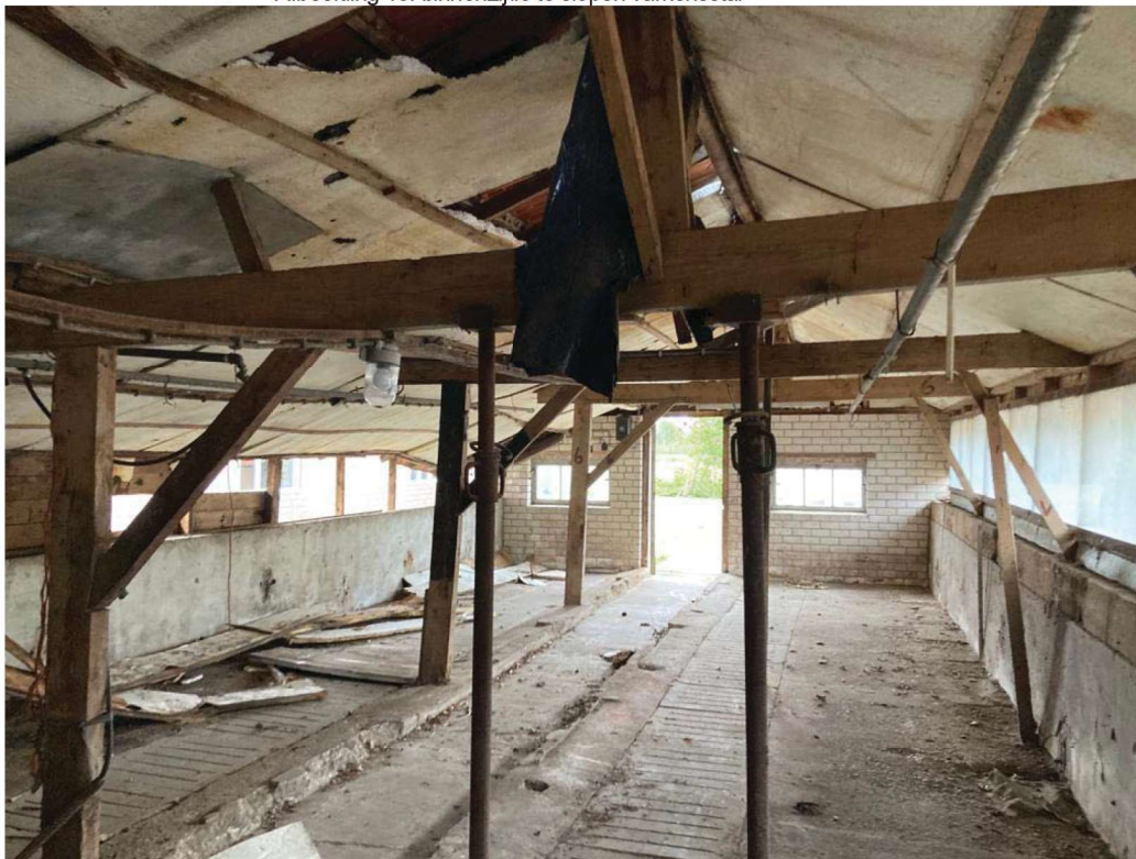
• Afbeelding 10: binnenzijde te slopen varkensstal
