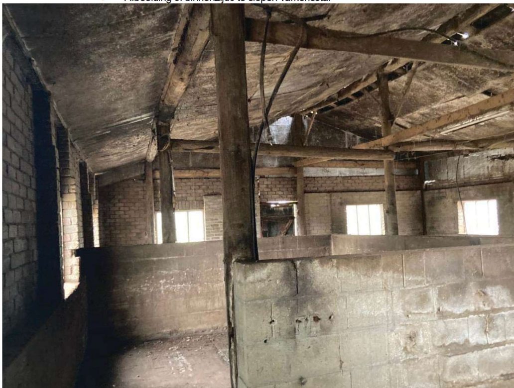
• Afbeelding 9: binnenzijde te slopen varkensstal
