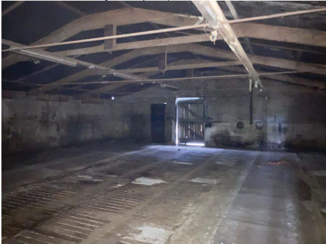
• Afbeelding 14: binnenzijde te slopen varkensstal
