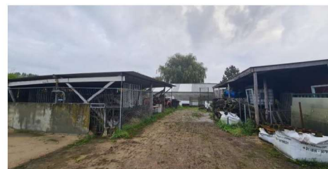
Figuur 5: Schuren gezien vanuit het noorden
