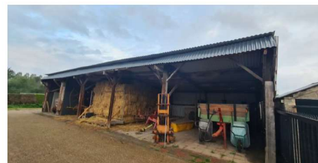
Figuur 6: Open kap schuur gezien vanuit het zuiden
