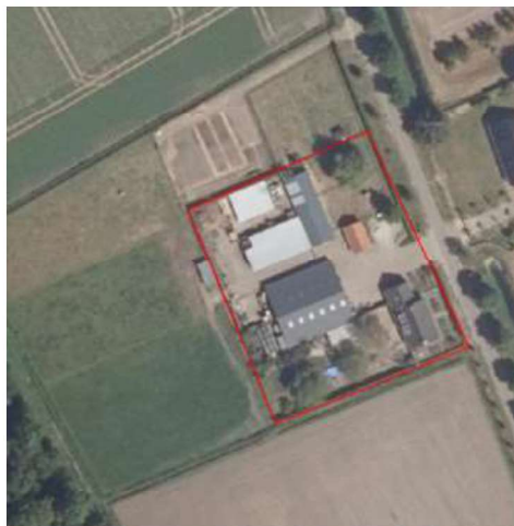
Figuur 4: Overzicht bebouwing binnen het projectgebied (bron: Google Maps)
