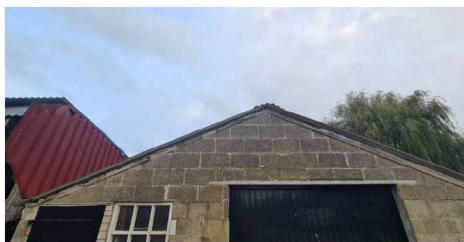
Figuur 7: Dakrand schuur
