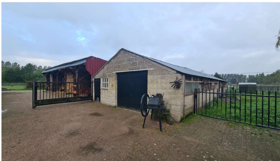
Figuur 4: Plangebied, met de twee te slopen schuren, gezien vanuit het zuidoosten
