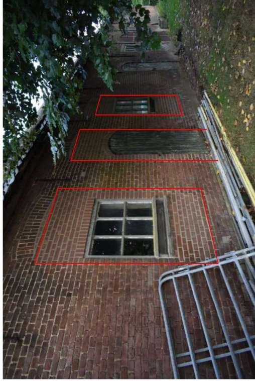
Voorgevel woongedeelte met in rood de oorspronkelijke gevelopeningen.
