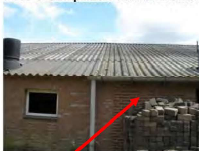
Foto 8 Overgang asbesthoudend/asbestvrije golfplaten
