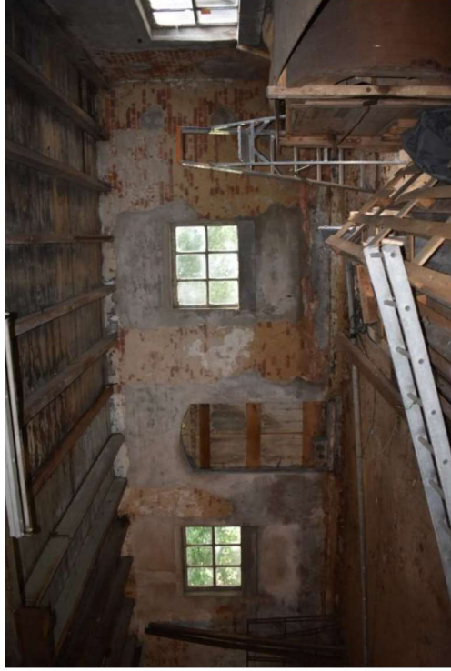
Interieur woongedeelte richting het zuiden.
