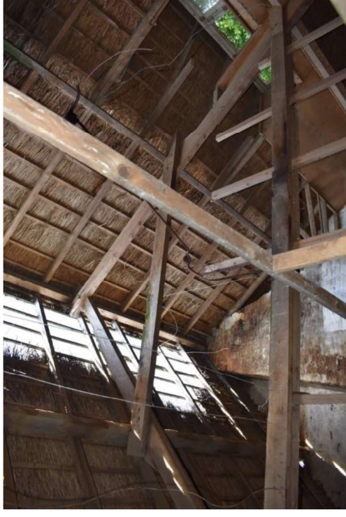
A-spant boven woongedeelte.
