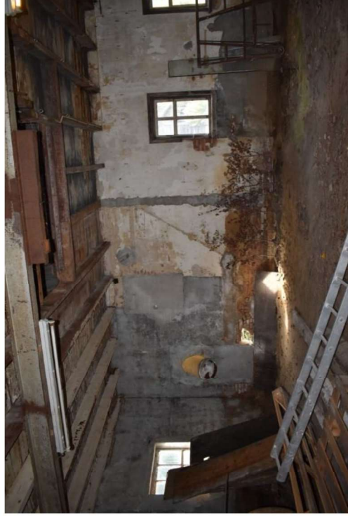
Interieur woongedeelte richting het noorden.
