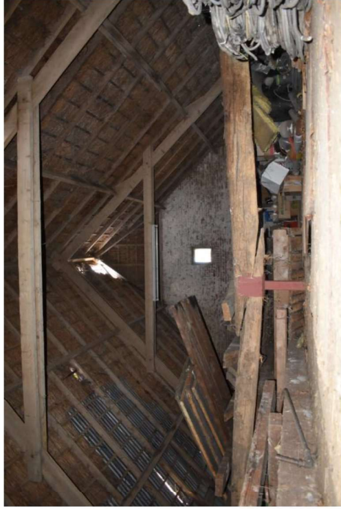
Verdieping boven schuurgedeelte met de hoger geplaatste moerbalk.
