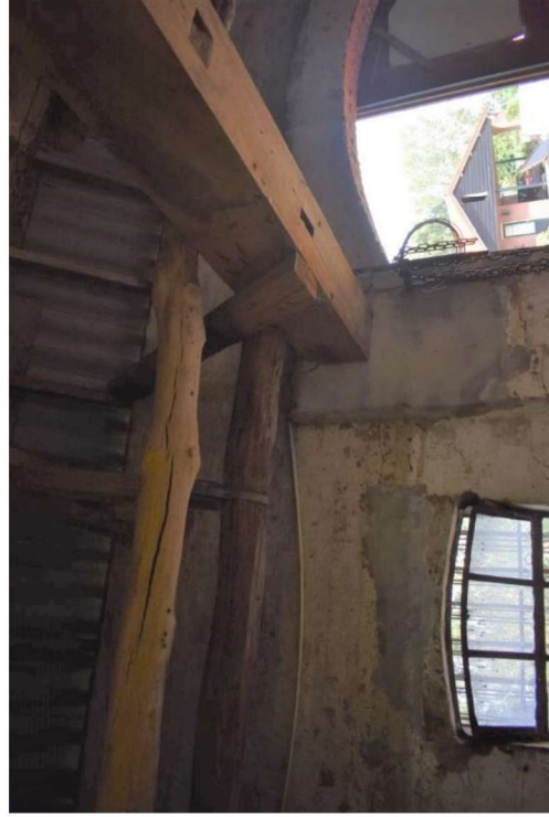
Vernieuwde balk in het stalgedeelte.
