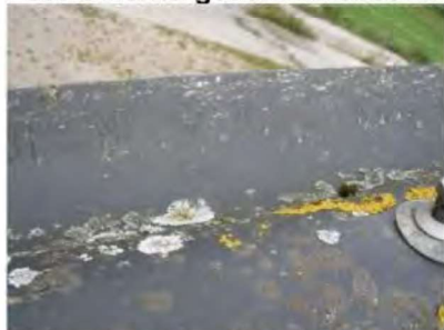
Foto 7 Asbestvrije golfplaten op varkensstal
