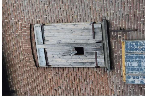
Oorspronkelijke toog en dorpel.
