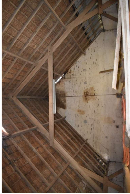
Verbeterd Hollands spant boven het stalgedeelte.
