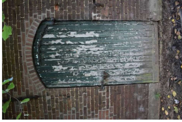
Loopdeur in voorgevel.
