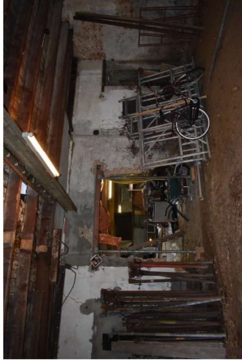
Interieur woongedeelte met brandmuur richting het oosten.
