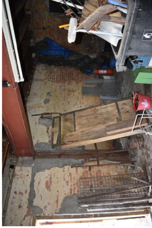
Vernieuwde balk in het schuurgedeelte.
