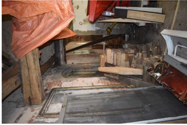
Moerbalk in de muur.
