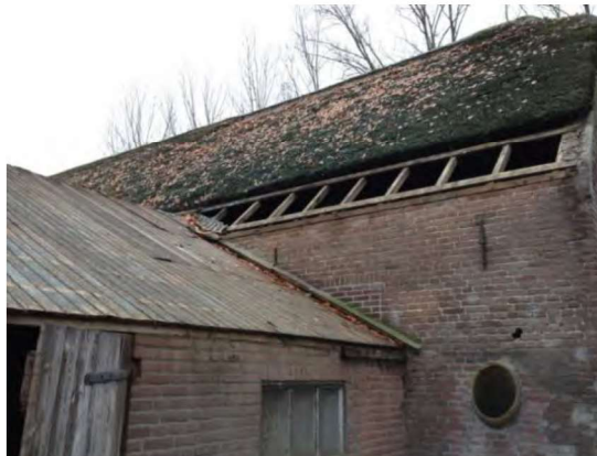
Foto 1 en 2: Het dak van de aanbouw is verwijderd.
