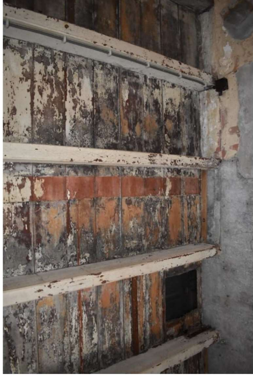
Samengestelde balklaag boven woongedeelte.
