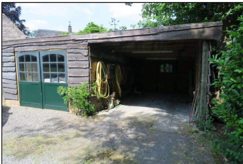
Figuur 3 De te slopen garage.
