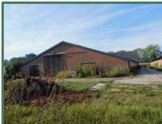
Overzicht achterzijde oostelijke stal
