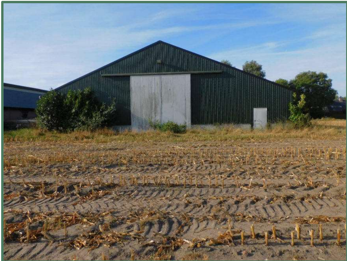
Achterzijde westelijk gelegen loods
