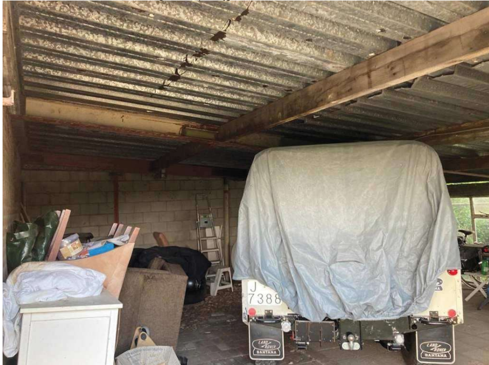
• Afbeelding 6: te slopen bijgebouw
