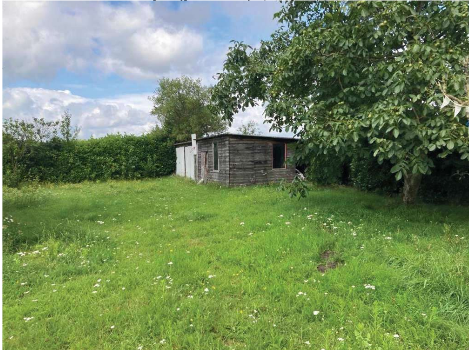
• Afbeelding 18: bijgebouw achterzijde (wordt gesloopt)
