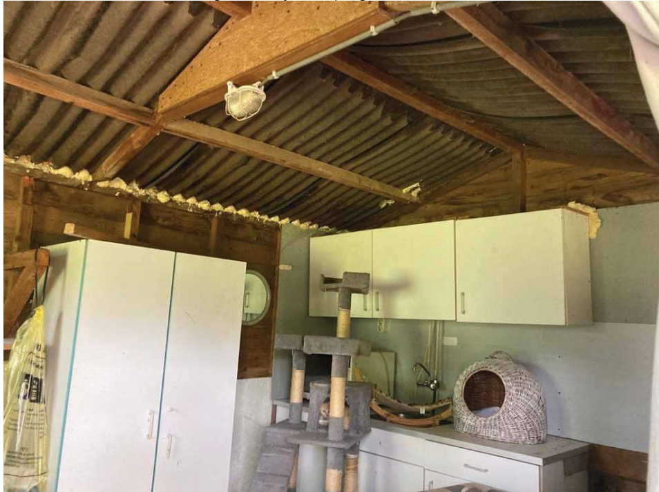
• Afbeelding 8: binnenzijde te slopen gebouw
