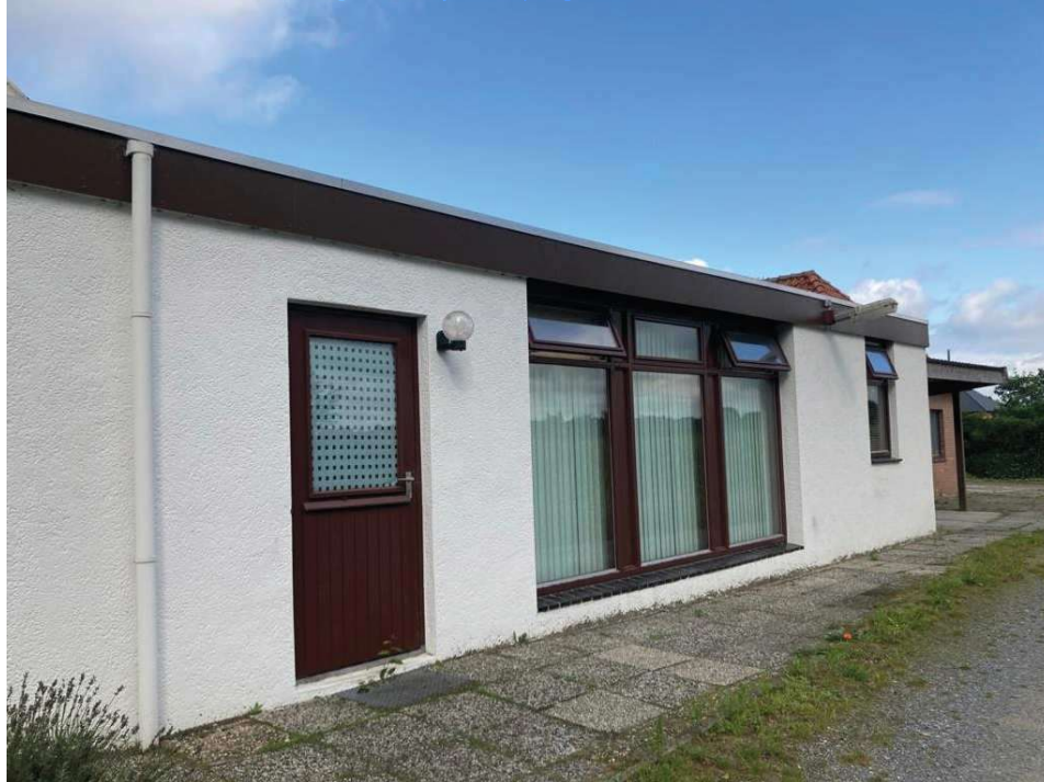
• Afbeelding 3: achterzijde te slopen gebouw
