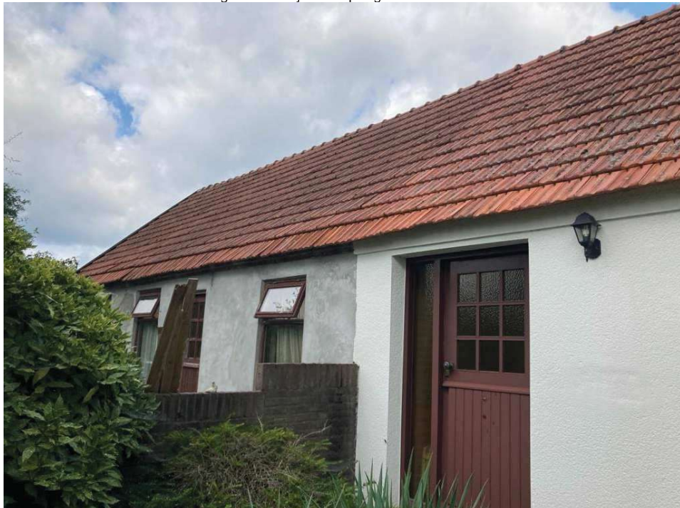
• Afbeelding 11: buitenzijde te slopen gebouw
