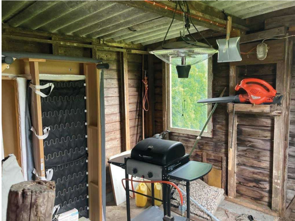
• Afbeelding 20: binnenzijde te slopen bijgebouw met opslag diversen
