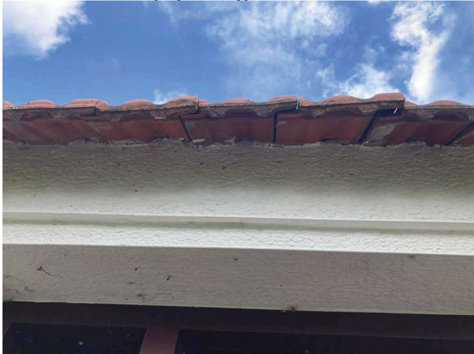
• Afbeelding 12: gebouw volledig gesloten met cement
