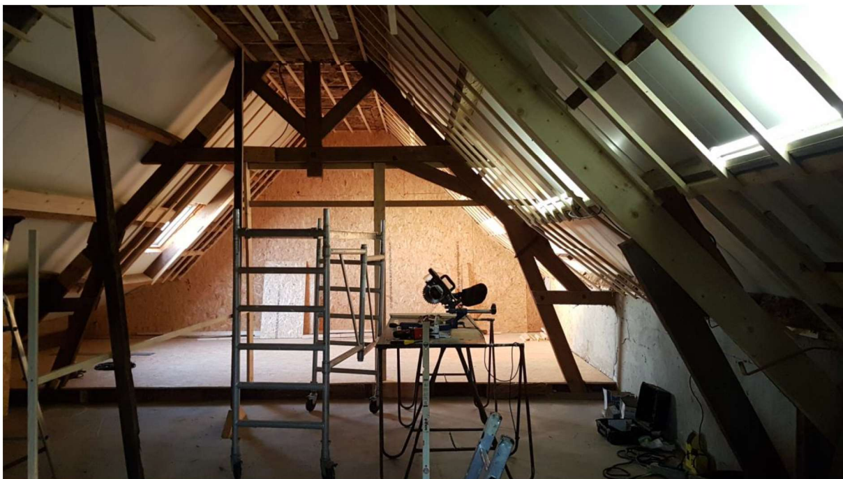
Foto 1: Binnen de langgevelboerderij waar gerenoveerd wordt.
