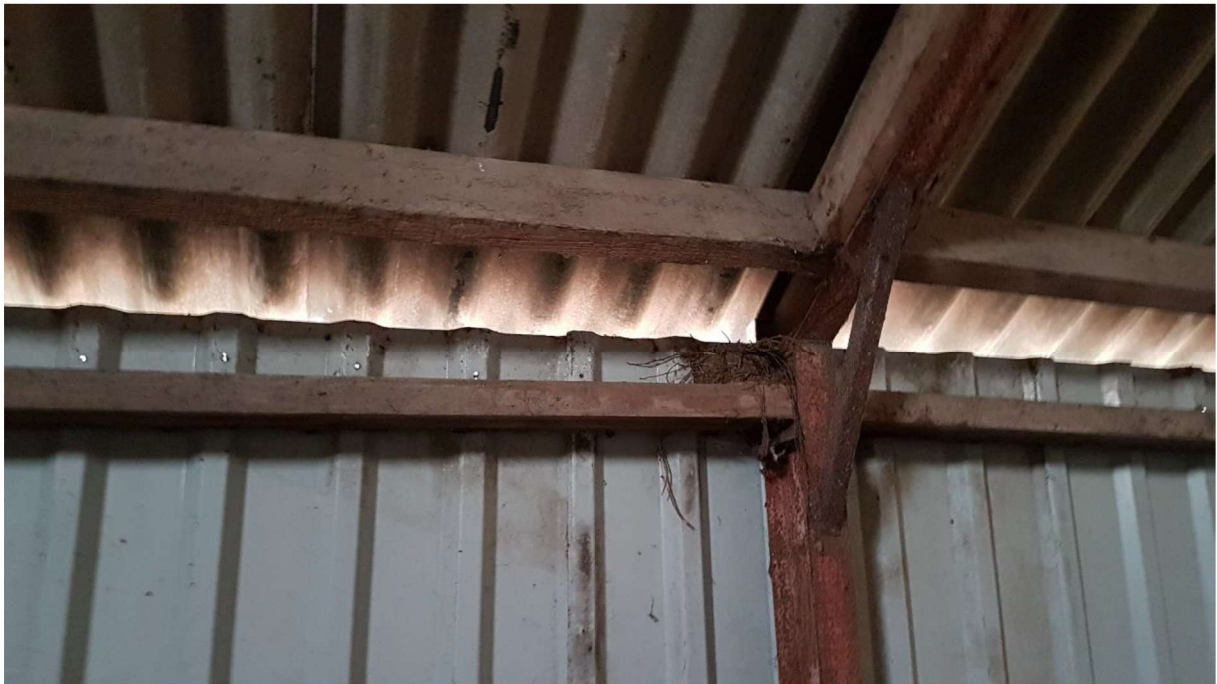
Foto 11: de opbouw van de schuur met metalen golfplaten.
