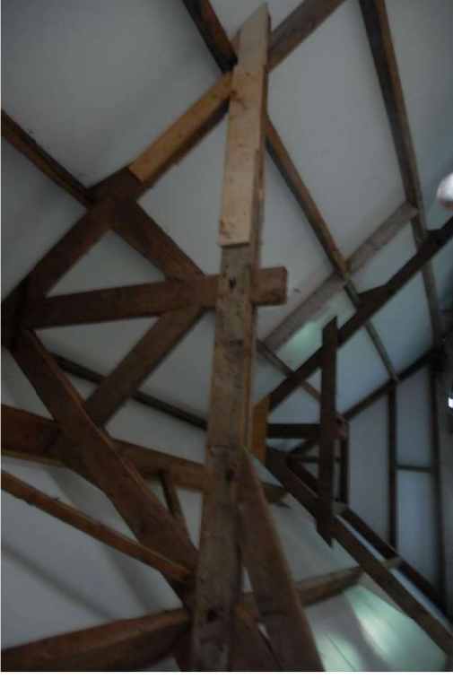
Detail kapconstructie blikrichting schilddak.
