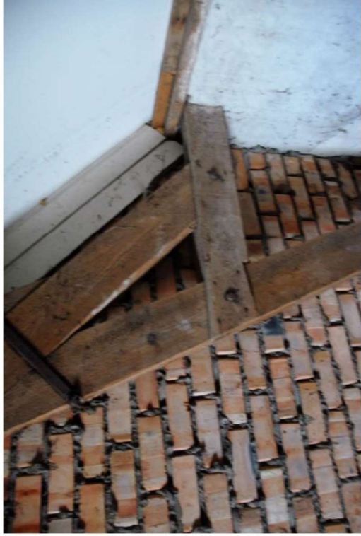
Detail spant met boutverbinding.
