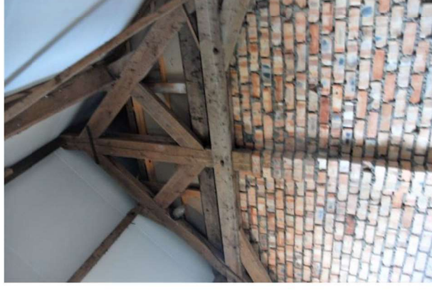
Spant aan deel bedrijfs gedeelte
