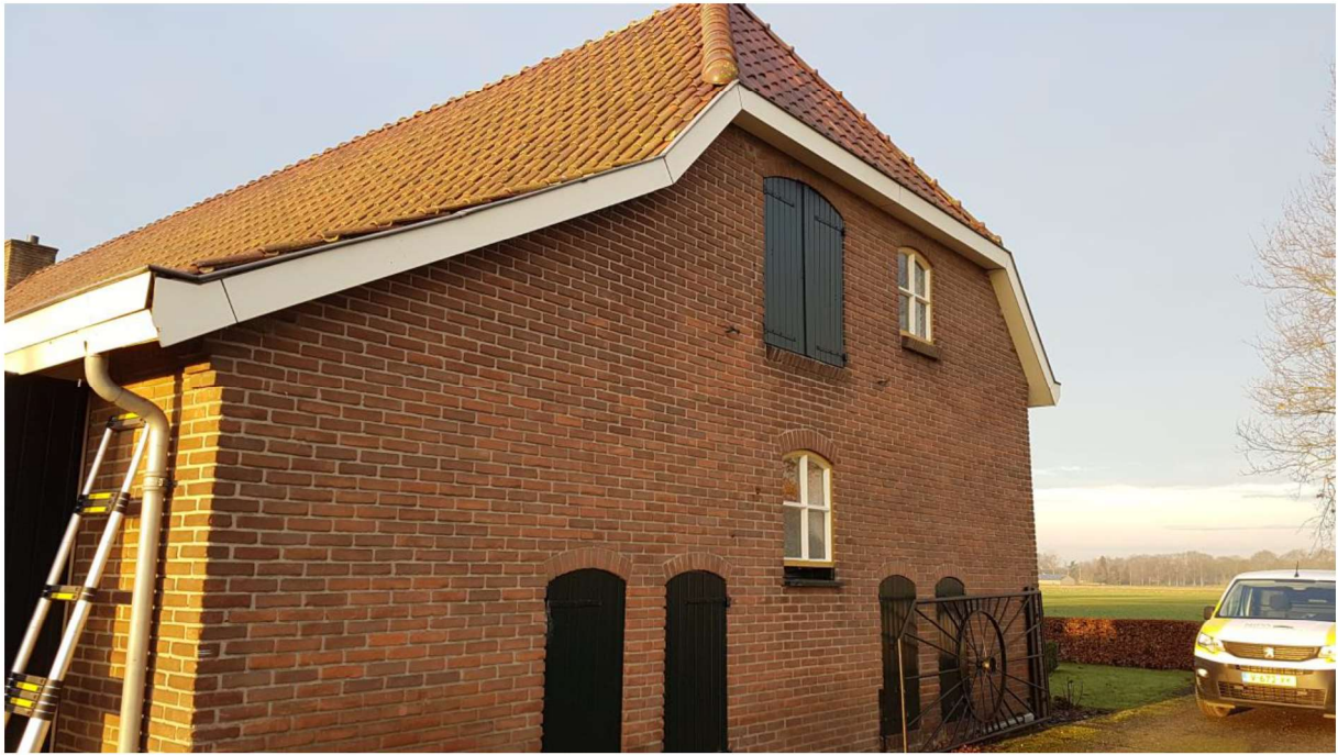
Foto 7: deuren in de gevel waarvan alleen de bovenste nog open is aan de achter zijde.
