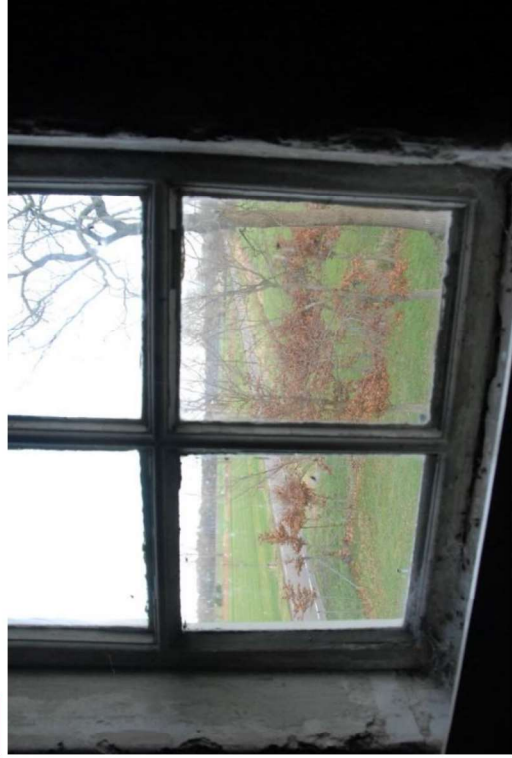
Linkerzijgevel op verdieping betonnen stalraam.
