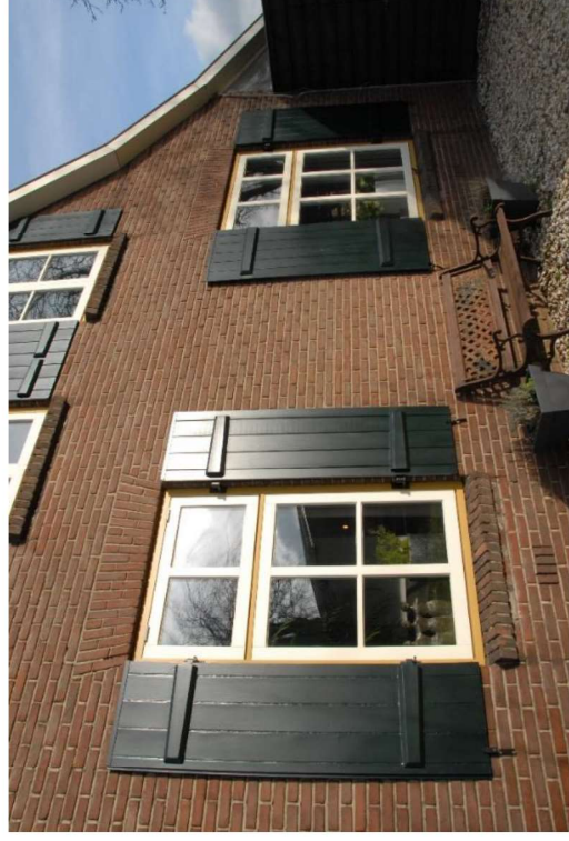
Rechterzijgevel, venster onder strek en gemetselde lekdoorpel met Luiken. Onder venster zijn ontluuchtingsgaten aanwezig.
