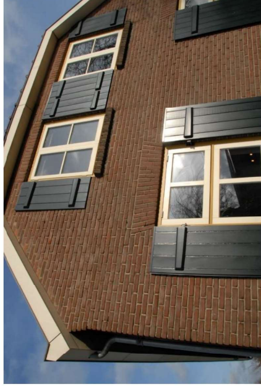
Rechterzijgevel. Vensters op de verdieping.
