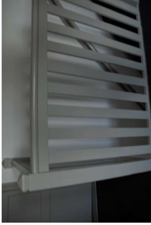
Balustrade bij trap woongedeelte.
