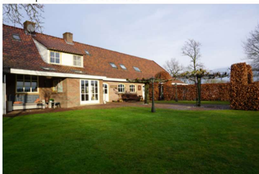
Figuur 2.11 Foto verharding achtergevel foto-opname 29-12-2021
