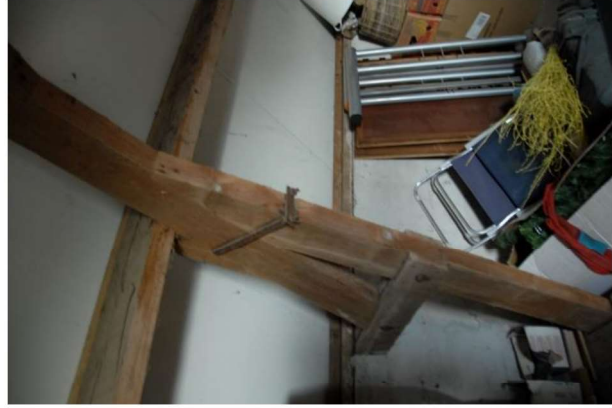
Detail spant met boutverbinding.
