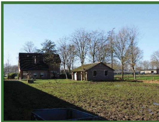
Achterzijde te behouden woning
