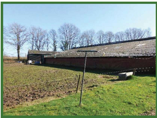
Zijgevel te slopen stal met loods erachter
