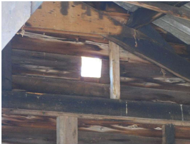
Opening in westelijke kopgevel van de kapschuur.
