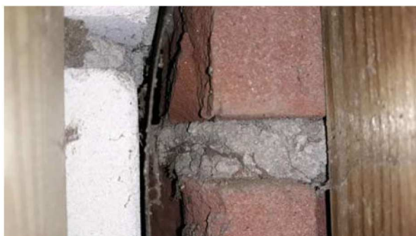
Spouwmuur niet asbestverdacht
