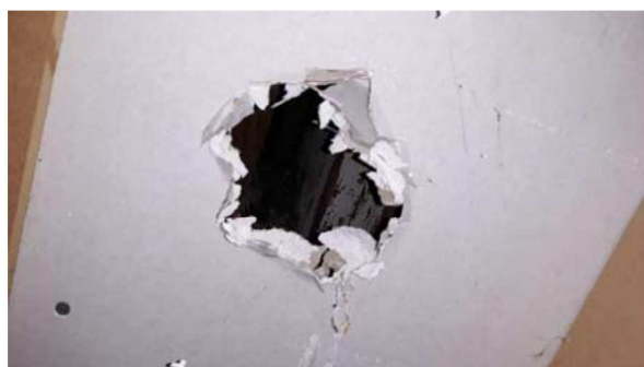
Niets asbestverdachts aangetroffen achter gipsplaten
