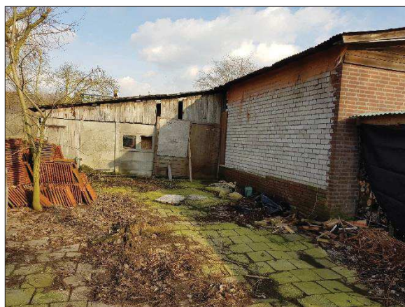
Figuur 9. Aanbouw noordzijde schuur
