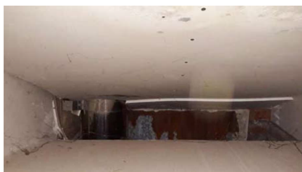
Gips beplating boven rookkanaal
