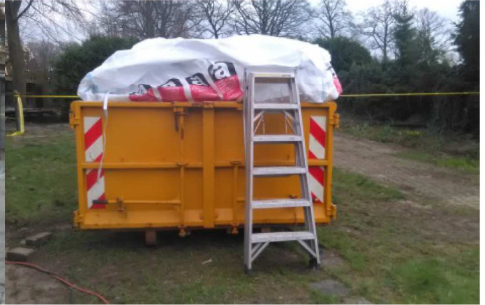
toelichting foto: afvalcontainer met dubbel verpakt asbestmateriaal rondom geïnspecteerd
