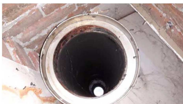
Buis in rookkanaal niet asbestverdacht
