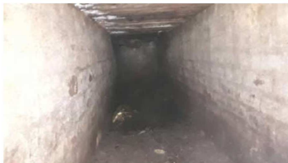
Smeerput niet asbestverdacht
