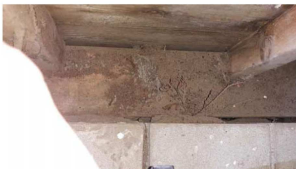
Houten afdekplaat spouwmuur
