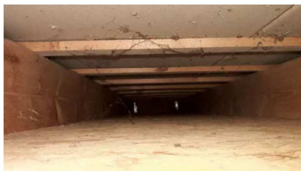
Boven aftimmering plafond, niet asbestverdacht
