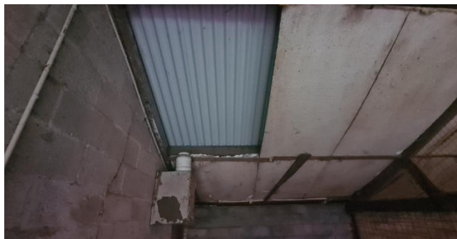
Figuur 8: Binnenzijde schuur
