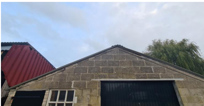
Figuur 7: Dakrand schuur
