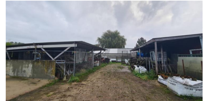
Figuur 5: Schuren gezien vanuit het noorden
