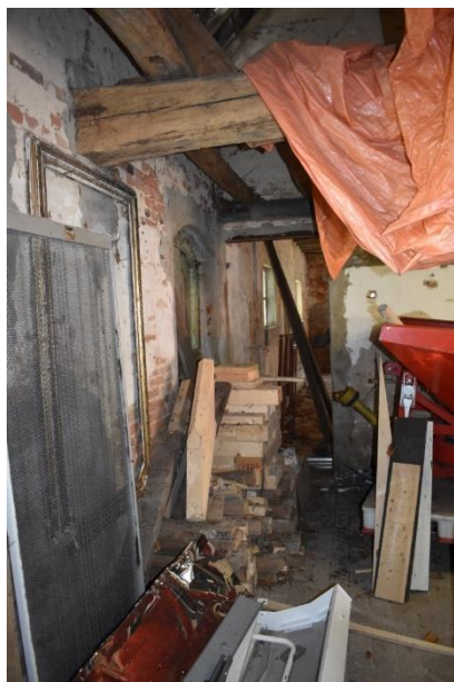
Moerbalk in de muur.
