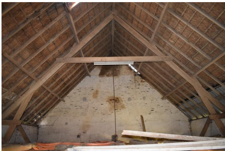
Verbeterd Hollands spant boven het stalgedeelte.
