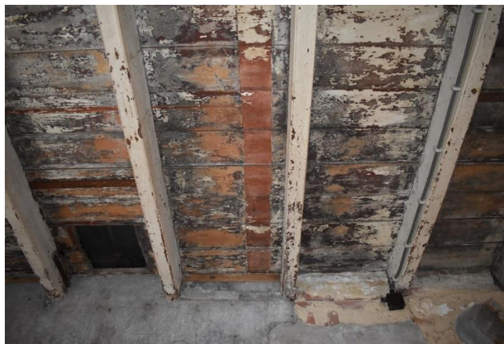
Samengestelde balklaag boven woongedeelte.
