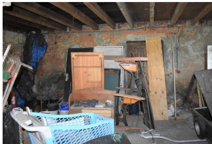
Schuurgedeelte met nieuwe balklaag.
