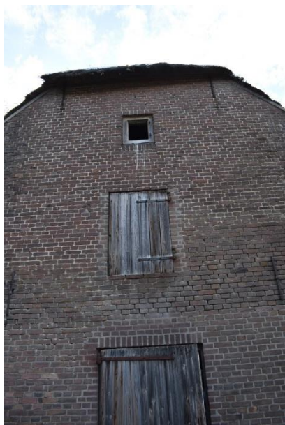
Oorspronkelijke opening boven met daaronder latere toevoegingen. Later aangebrachte paardenstal deur.
