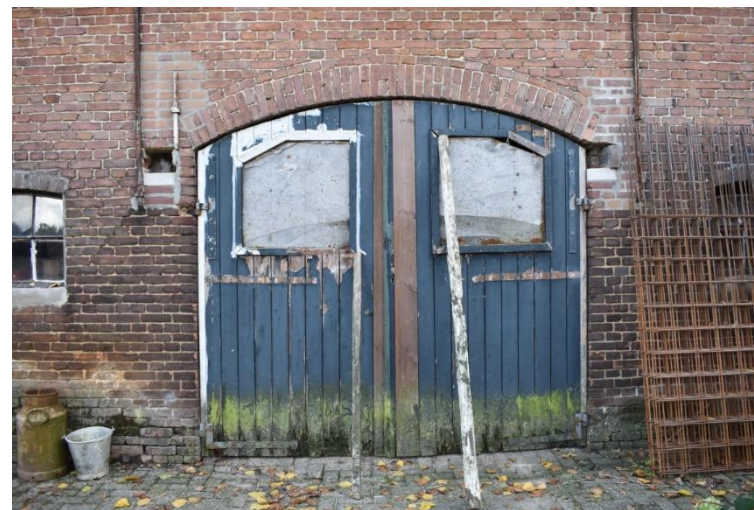
Vernieuwde deel deur waar oorspronkelijk een potstal deur zat.
