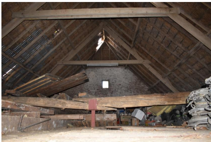
Verdieping boven schuurgedeelte met de hoger geplaatste moerbalk.
