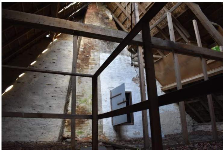
Brandmuur met rookkanaal.
