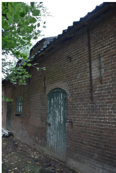
Voorgevel van het woongedeelte.
