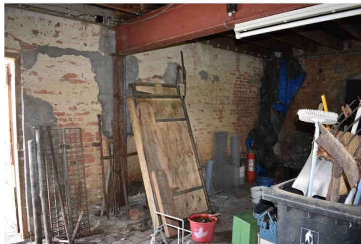
Vernieuwde balk in het schuurgedeelte.
