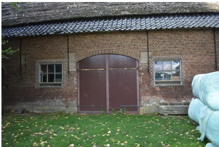
Vernieuwde deel deur, voorheen potstal deur.
