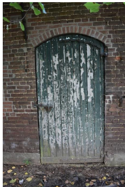
Loopdeur in voorgevel.
