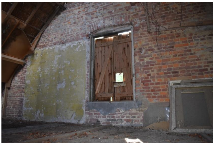
Zolder boven woongedeelte.
