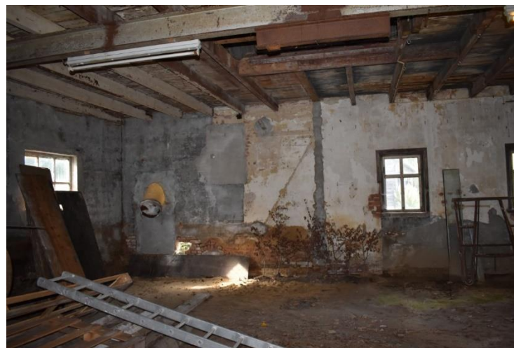
Interieur woongedeelte richting het noorden.
