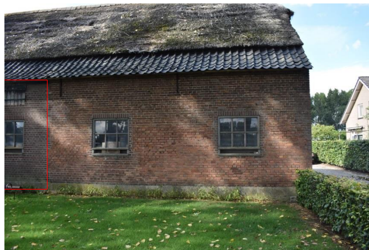
Voorgevel bedrijfs gedeelte met in rood de dichtgemetselde opening van de grote deel deuren.
