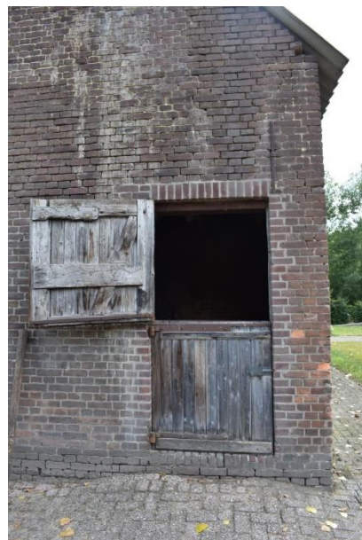
Oorspronkelijke opening boven met daaronder latere toevoegingen. Later aangebrachte paardenstal deur.
