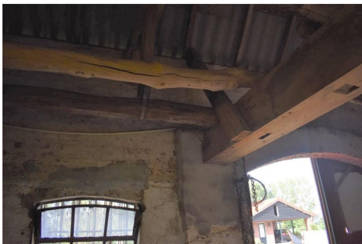
Vernieuwde balk in het stalgedeelte.
