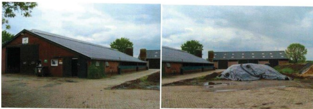
Afb. 5 Bestaande toestand stal met naastliggende kuilplaten. Links: Stal. Rechts: kuilplaten.
