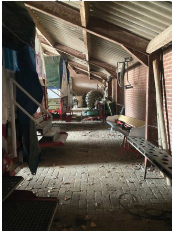
• Afbeelding 9: opslag diversen in schuur
