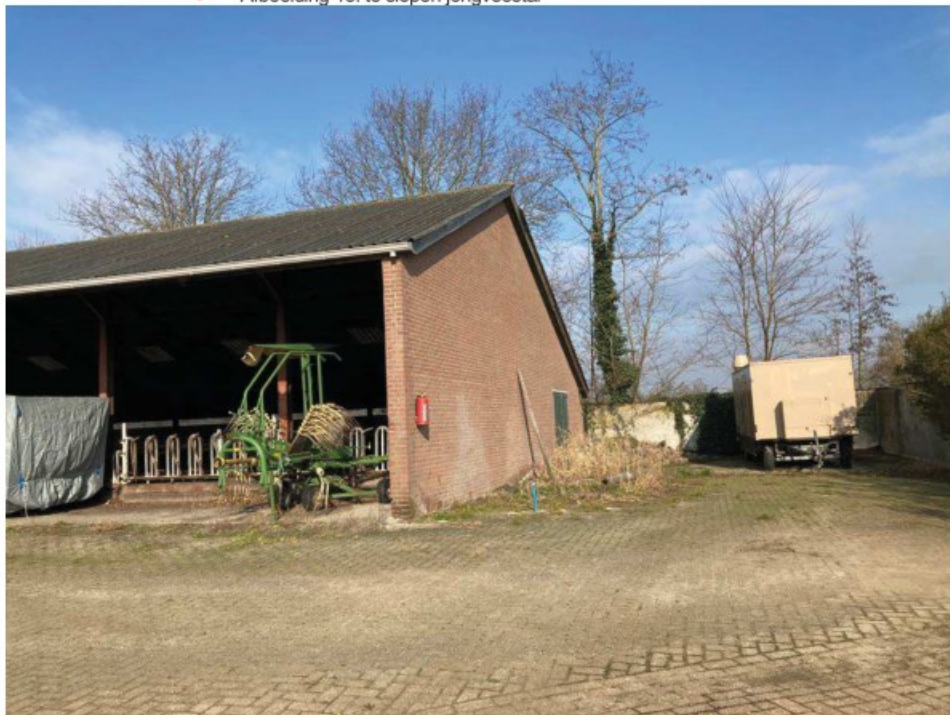
• Afbeelding 13: te slopen jongveestal
