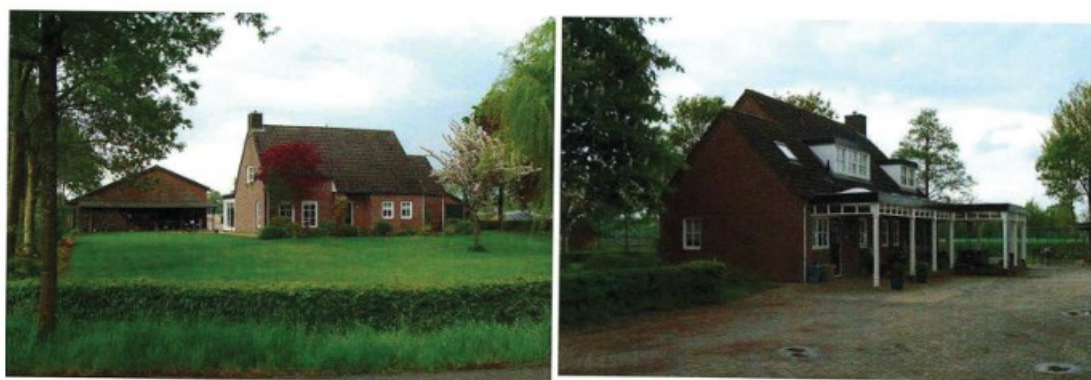
Afb. 4 Bestaande toestand woonhuis. Links: voorzijde. Rechts: achterzijde.
