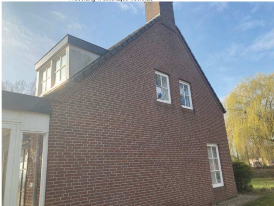
• Afbeelding 4: buitenzijde woonhuis
