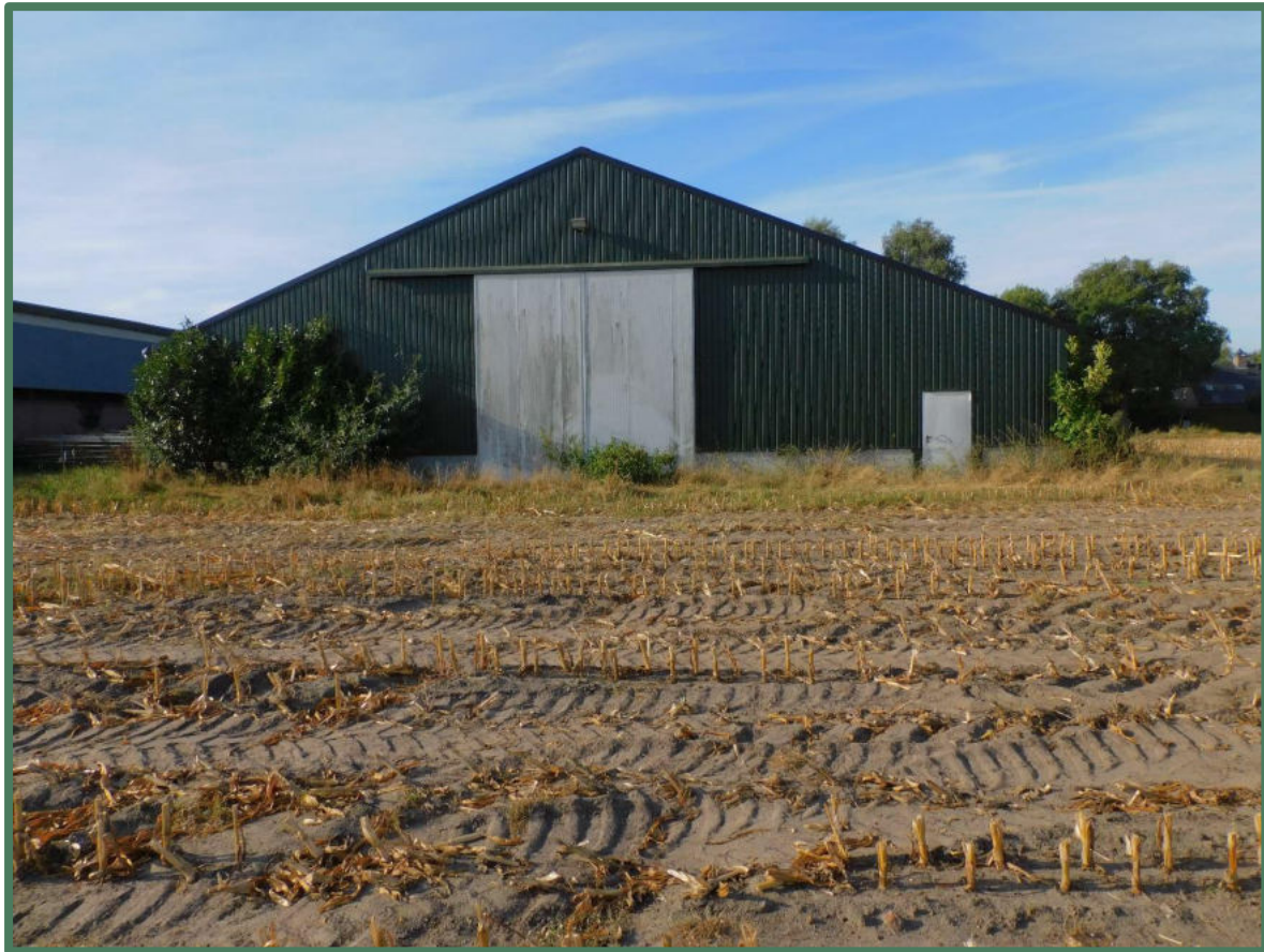
Achterzijde westelijk gelegen loods
