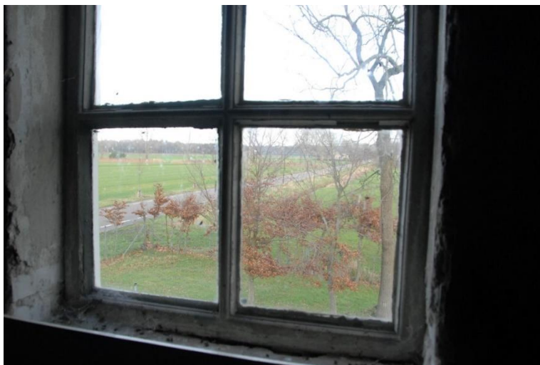
Linkerzijgevel op verdieping betonnen stalraam.
