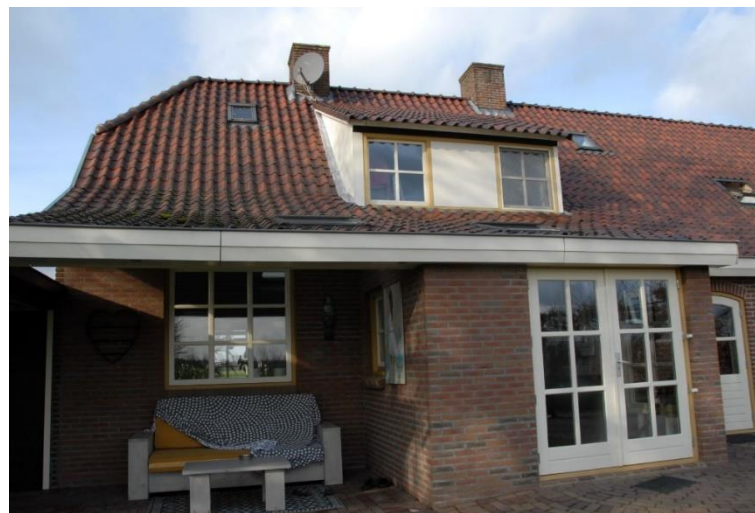
Achtergevel. Links van de aanbouw is nog een stukje oorspronkelijke gevel, wel met vernieuwd venster.
