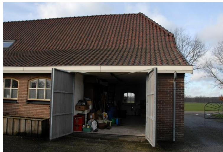
Achtergevel met openslaande deeldeuren.
