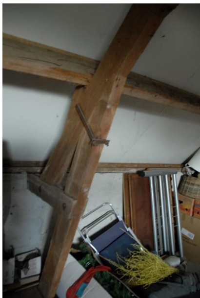
Detail spant met boutverbinding.
