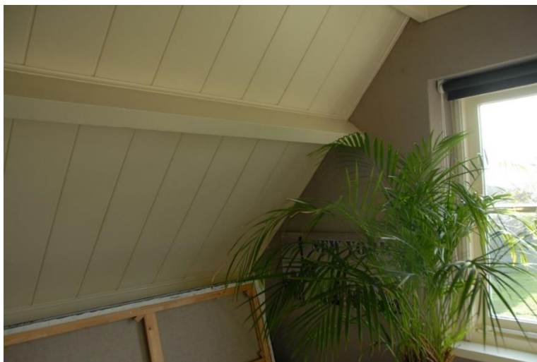
Slaapkamer met staanddakbeschot.
