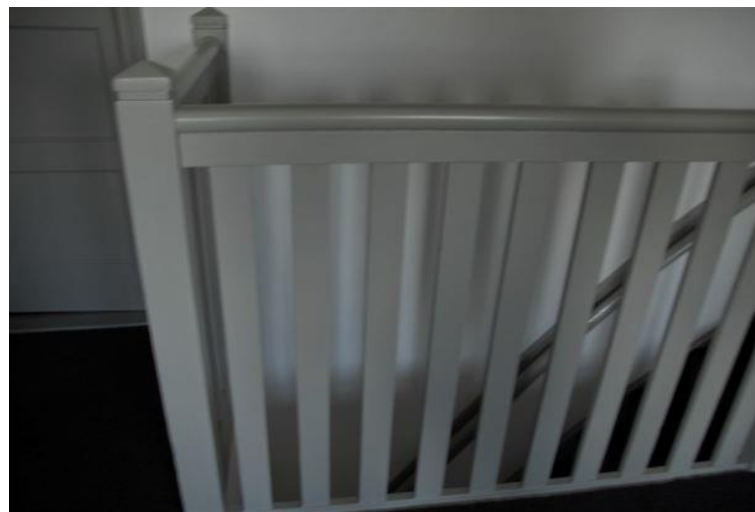
Balustrade bij trap woongedeelte.
