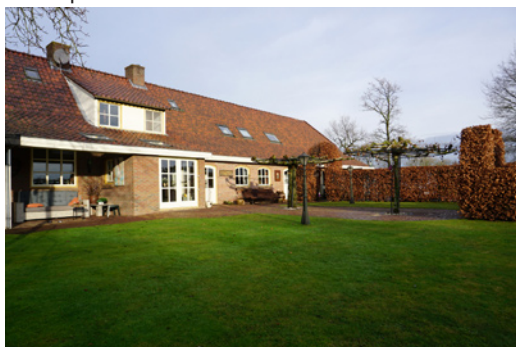
Figuur 2.11 Foto verharding achtergevel foto-opname 29-12-2021
