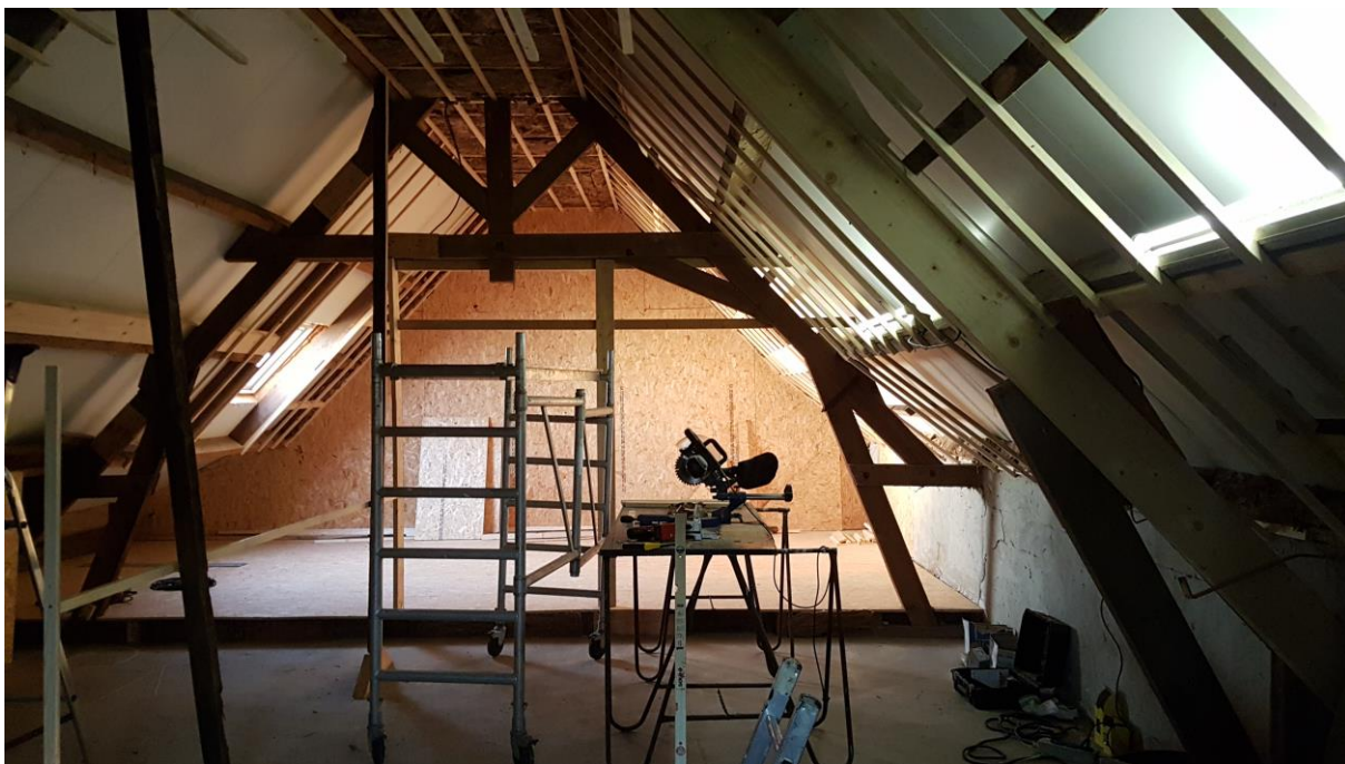
Foto 1: Binnen de langgevelboerderij waar gerenoveerd wordt.
