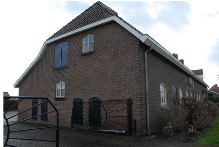
Linkerzijgevel met varkensdeuren, stalramen en hooiluik.
