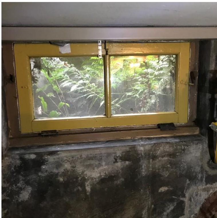
Kelderraam. Foto aangeleverd door eigenaar.
