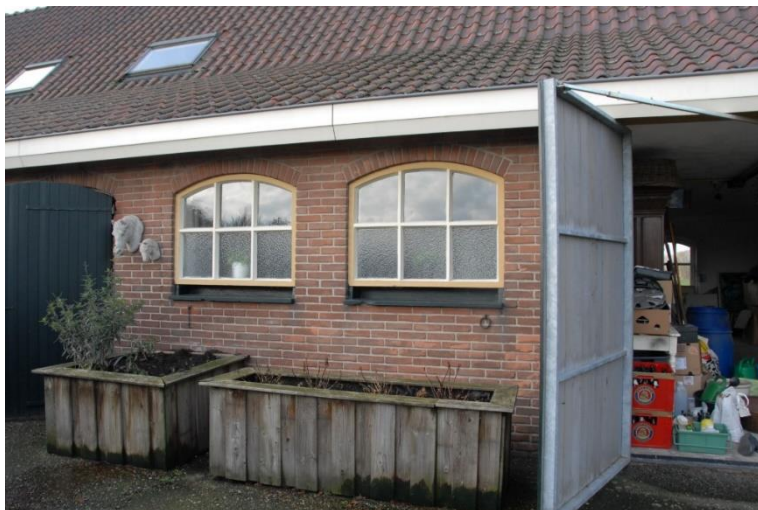
Achtergevel. Van links naar rechts: houten loopdeur, twee stalramen en (vernieuwde) deeldeuren.
