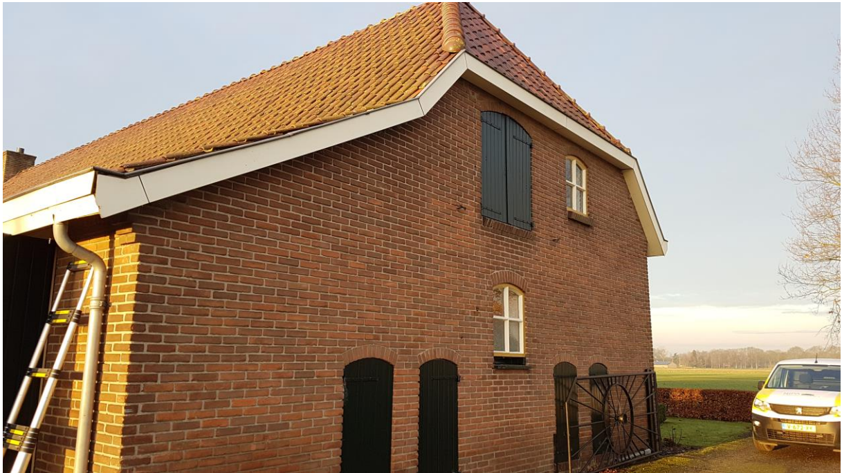
Foto 7: deuren in de gevel waarvan alleen de bovenste nog open is aan de achter zijde.
