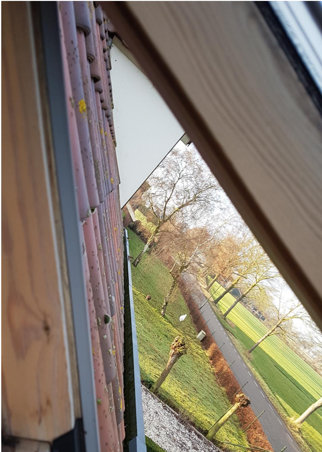
Foto 4: twee huismussen die in de goot aan het fluiten zijn en later onder de pannen weggropen.
