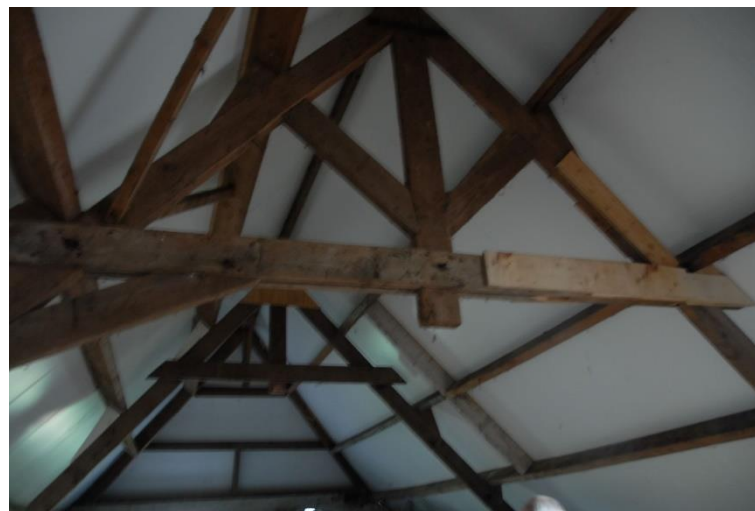
Detail kapconstructie blikrichting schilddak.
