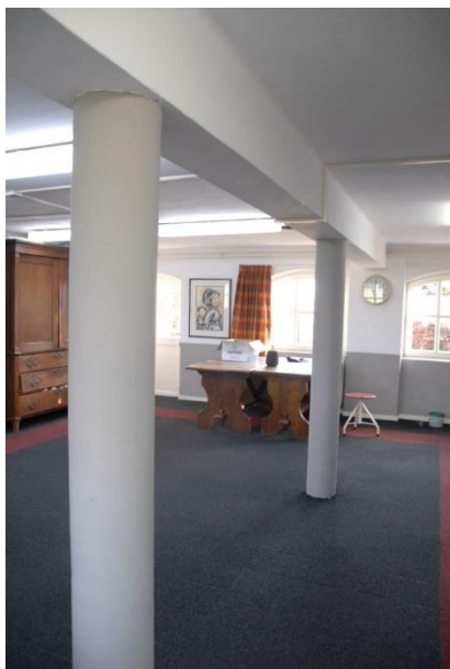
Betonnen kolommen voormalige koestal.
