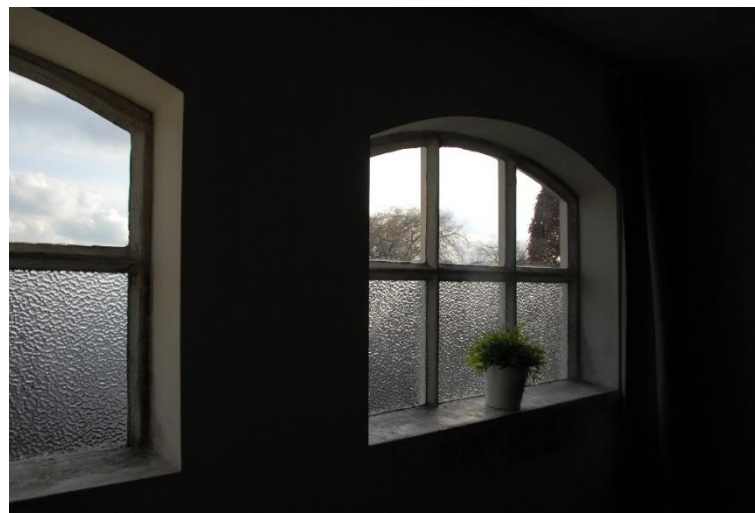
Oorspronkelijke betonnen stalramen met ventilatiegleuf.
