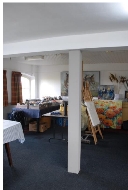
IJzeren dragende pijlers in voormalige koestal.
