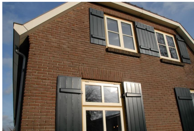
Rechterzijgevel. Vensters op de verdieping.
