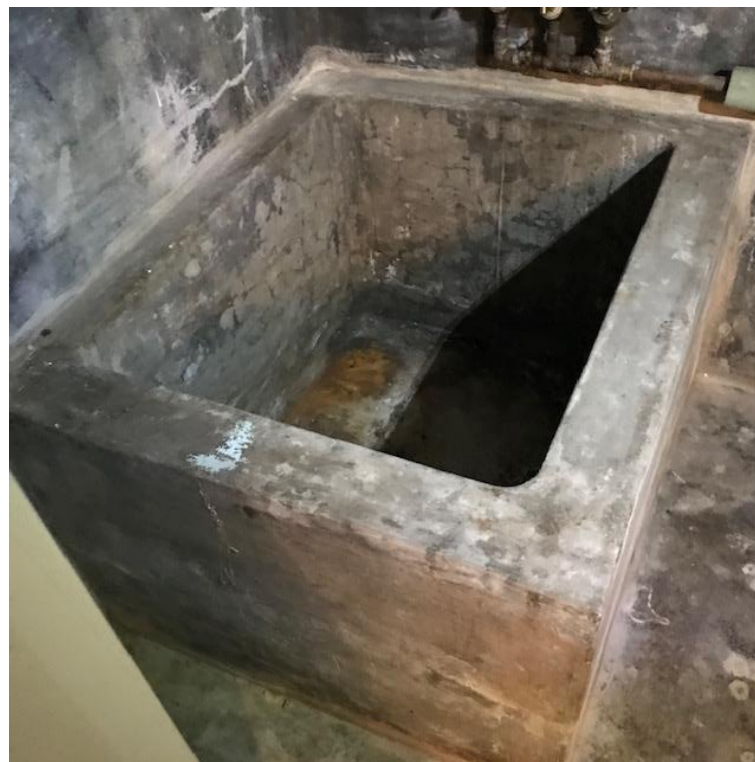
Pekelbak in kelder. Foto aangeleverd door eigenaar.
