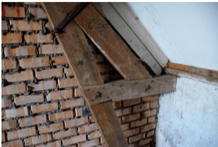
Detail spant met boutverbinding.
