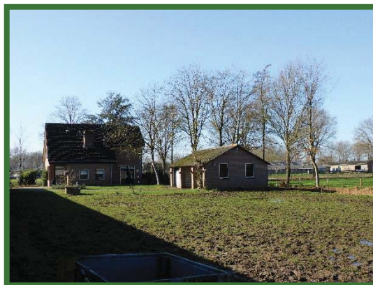
Achterzijde te behouden woning
