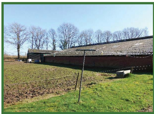
Zijgevel te slopen stal met loods erachter
