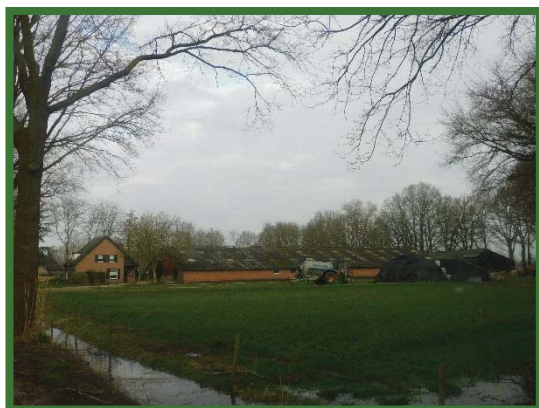
Aanzien vanaf de straat woning met te slopen stal
