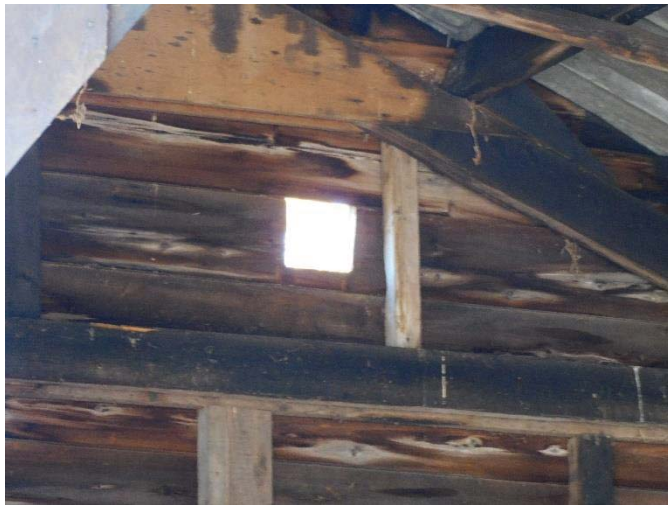
Opening in westelijke kopgevel van de kapschuur.
