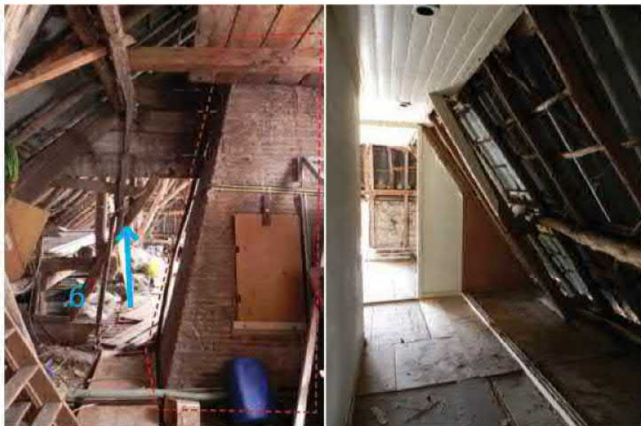
26 Op de zolder komen de constructies van de twee kappen bij elkaar. Links het gemetselde rookkanaal met 'spekluk'. 27 De rechtse foto toont de kapconstructie van het krukhuys. De spanten en gordingen zijn nauwelijks forser dan de daksporen. Daarnaast ontbreekt een spant en een kilkeper volledig.
