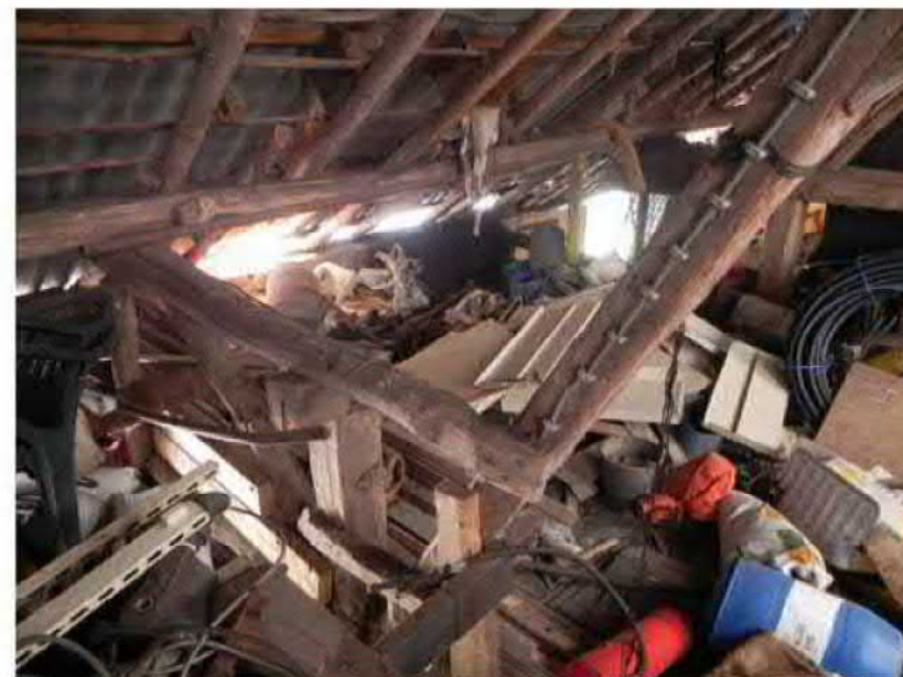
33 De constructie is meermaals aangepast wat tot een relatief zwak geheel heeft geleid. Zo ontbreekt van het gebint grotendeels het langsverband en windschoren van de spanten.
