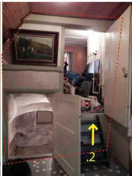
07 De oorspronkelijke kelder en de opkamer zijn bewaard gebleven. De huidige trapopgang is door een oude balklaag aangebracht.
