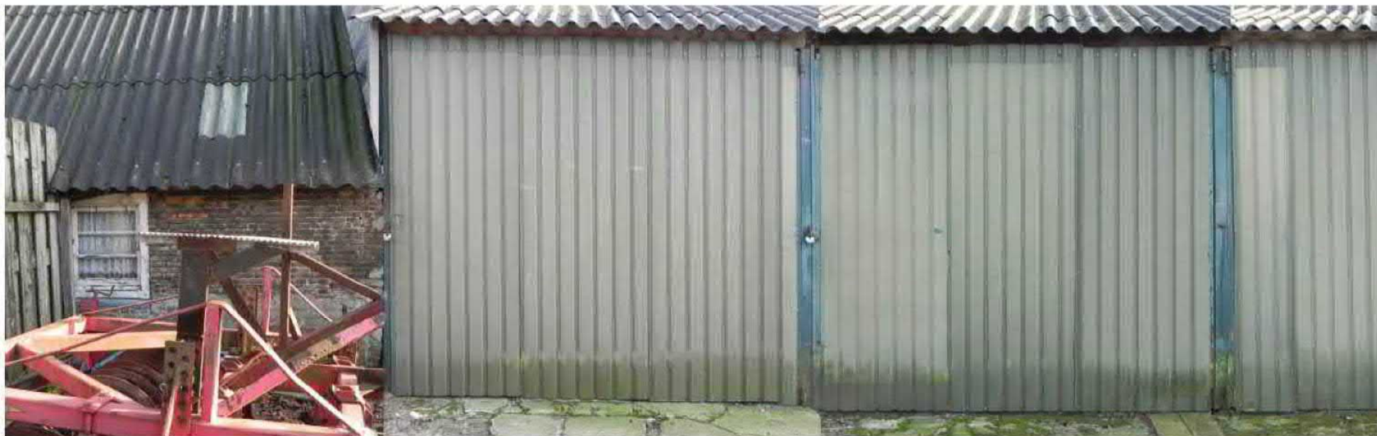
Gevel Noordwest (midden)
