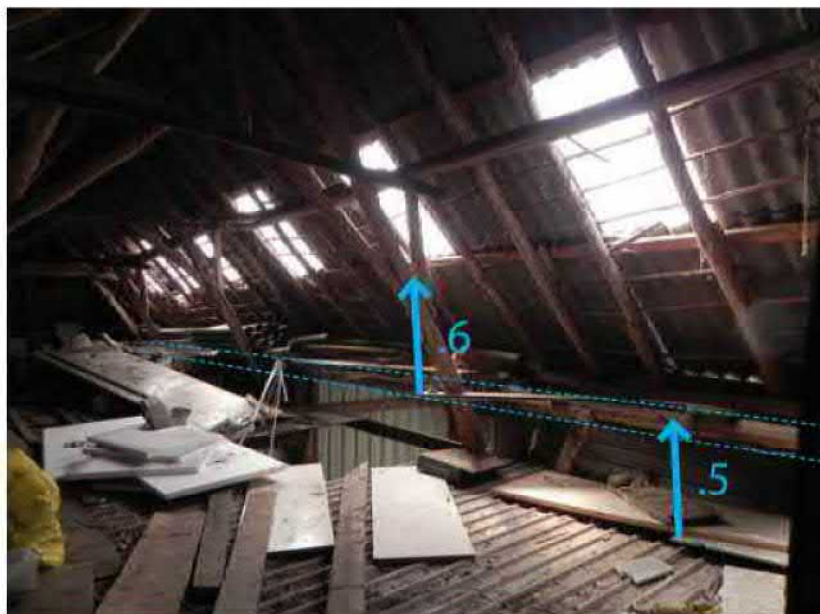
31 Kapconstructie met licht gedimensioneerde hulpconstructie.
