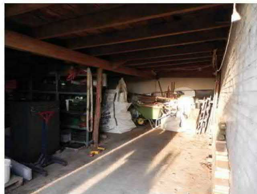
25 Voormalige in de schuur ingebouwde stal met nieuw houten zolderdek.
