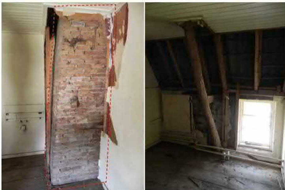
28 Rookkanaal van 'krukhuys' en spant met laag geplaatst venster 29.
