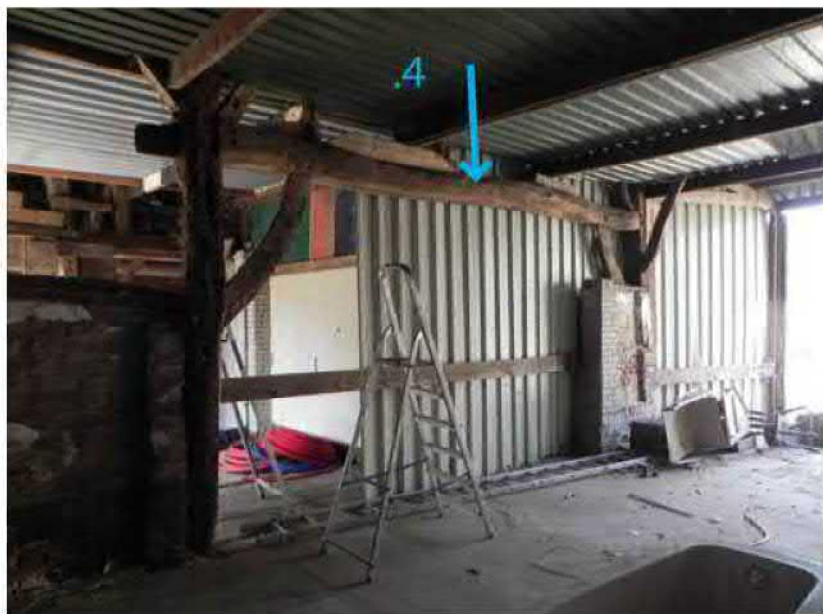
21 De wanden in de oude stal en schuurruimte zijn in stalen damwandprofielen uitgevoerd.
