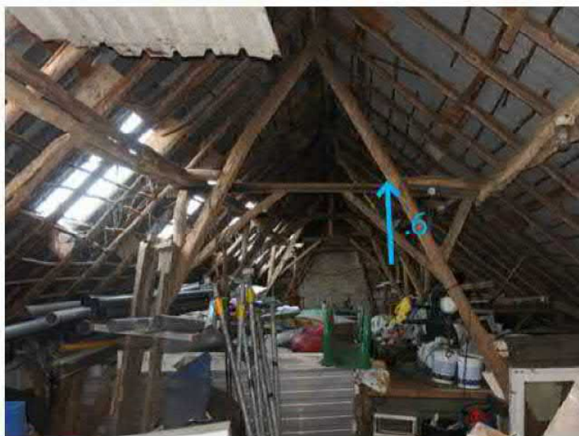
32 De voormalige hooizolder boven stal en schuur is nu als berging in gebruik. Aan de rechter zijde is goed te zien dat het dakvlak ten opzichte van een eerdere verhoging is
