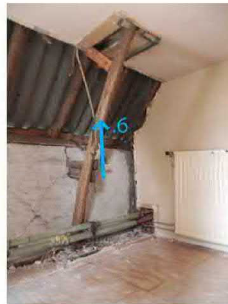
30 De gele pijl geeft een restant van de langspaat in de 'voorgevel' aan.
