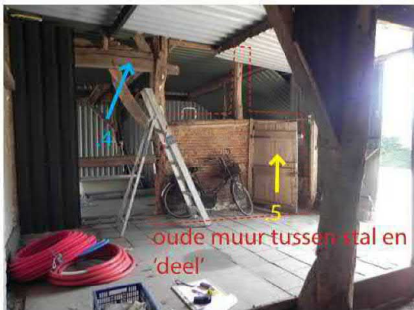
18 Interieur van voormalig stal- en schuurgedeelte met restant van scheidingswand en deur op stramien 4. Gebintstijlen C 3-4-5.
