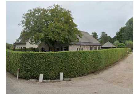
Langgevel met ruime tuin met huisboom
