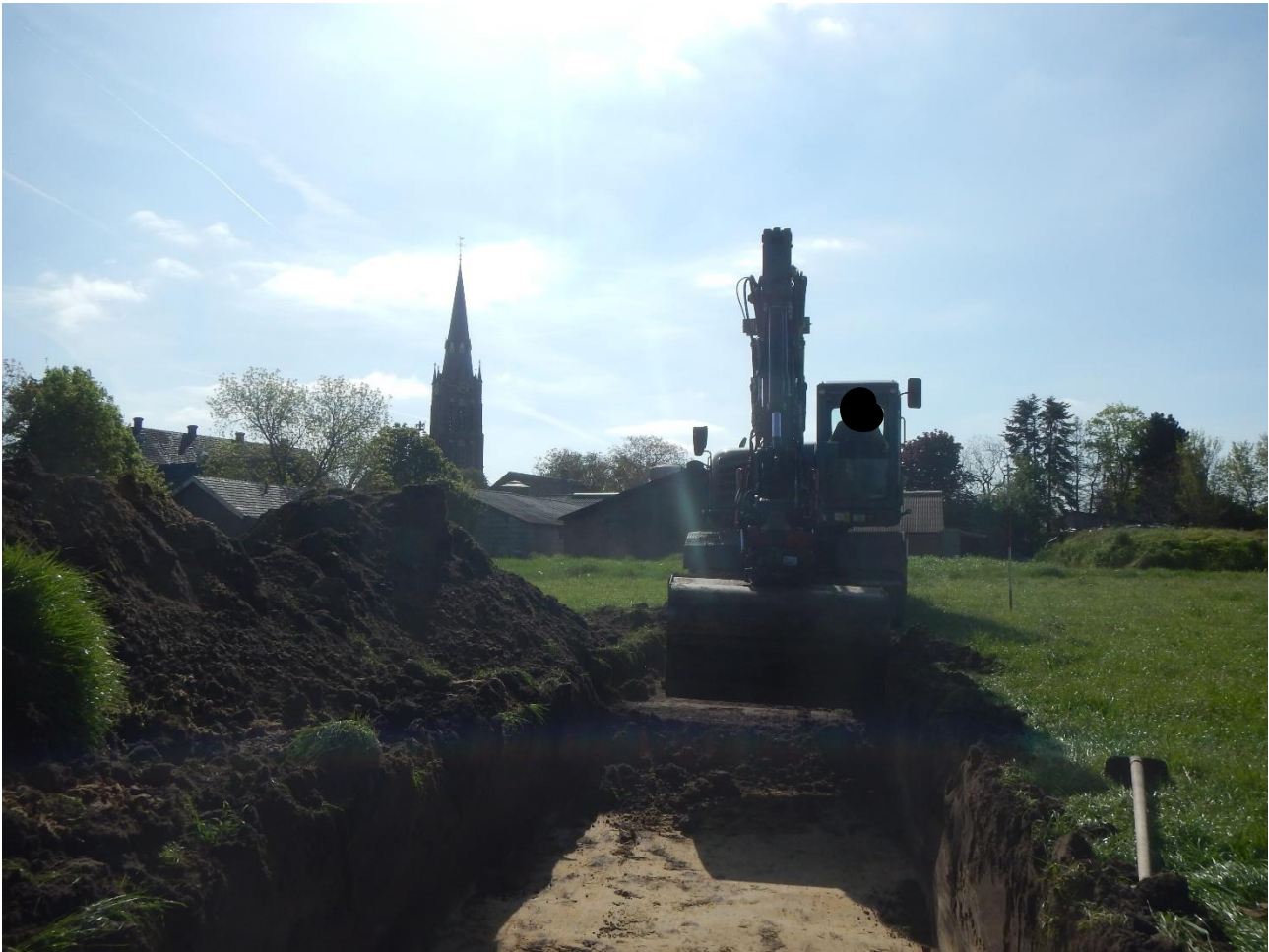
Afb. 5 Aanleg van werkput 2.
