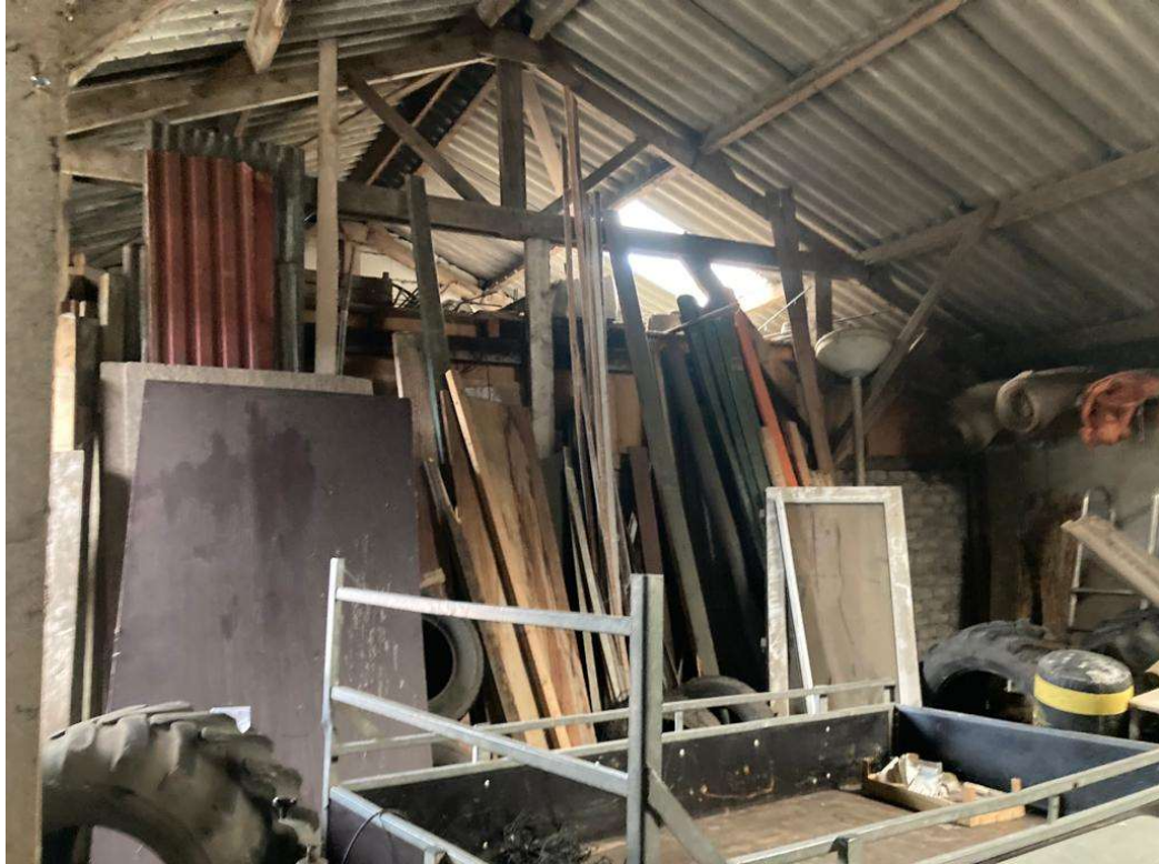
• Afbeelding 4: binnenzijde te slopen schuur met opslag diversen
