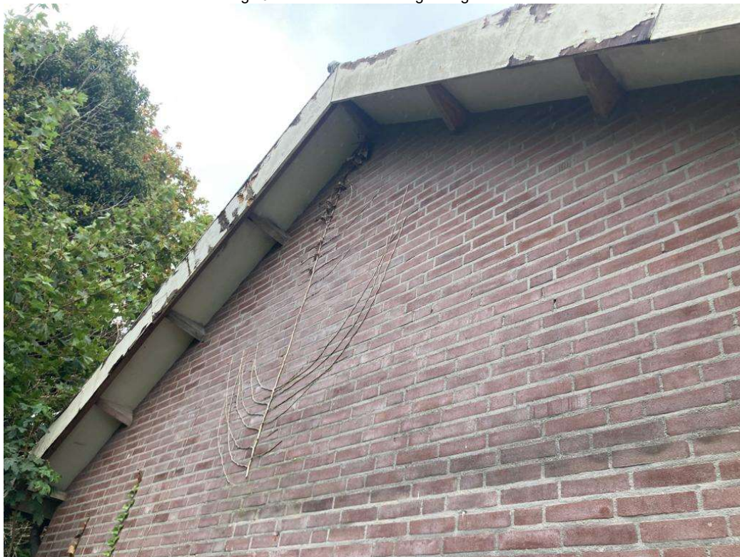
• Afbeelding 16: dakbeschoot mantelzorgwoning
