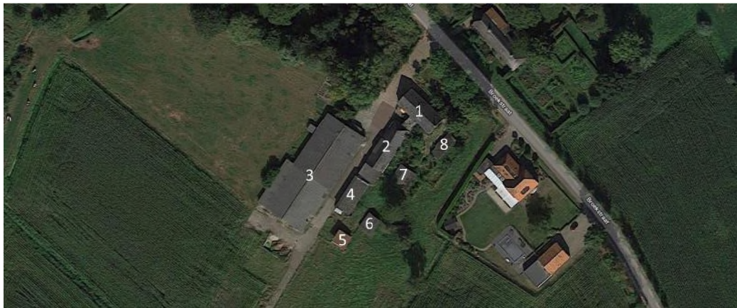
Figuur 1 Op het perceel zijn 8 gebouwen aanwezig, waarvan één woning en 7 voormalige stallen/opslagloodsen (bron: maps.google.com)
