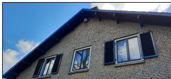
Foto 2. De dakrand van het woonhuis
