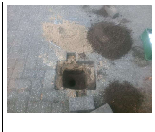
Foto 16. Asbestinspectiegat B17
