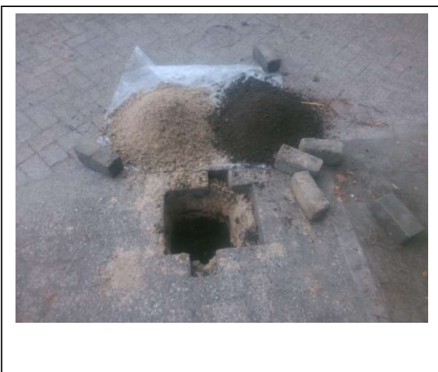
Foto 17. Asbestinspectiegat B18
