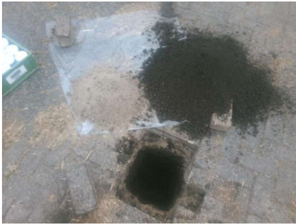
Foto 7. Asbestinspectiegat B07
