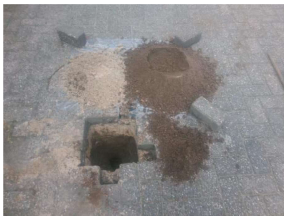
Foto 2. Asbestinspectiegat B02
