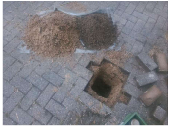
Foto 8. Asbestinspectiegat B09
