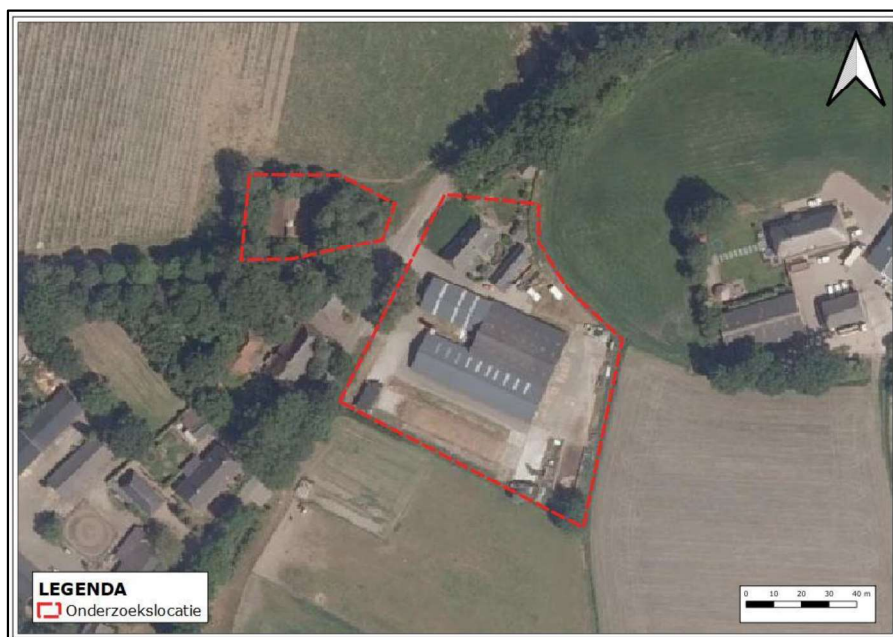
Figuur 2a. Luchtfoto onderzoekslocatie en directe omgeving.
