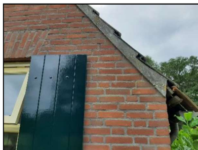
Figuur 10. Detailfoto luiken en specie bij kantpannen woonhuis.
