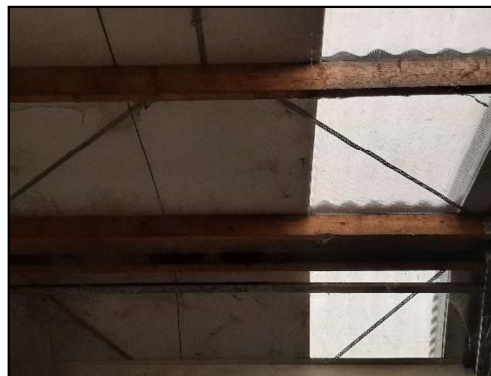
Figuur 25. Binnenzijde dak geitenschuur met betimmering.
