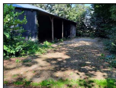
Figuur 17. De veldschuur.
