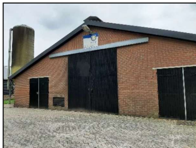
Figuur 4. Vooraanzicht westelijke deel geitenschuur gezien vanaf de Venstraat.
