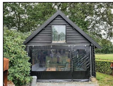
Figuur 11. Vooraanzicht van de opstal met overdekt terras achterin de tuin van het woonhuis.
