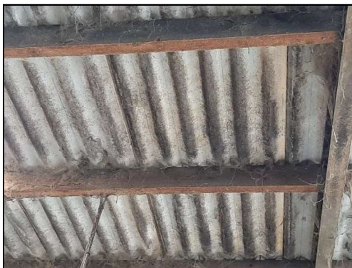
Figuur 24. Binnenzijde geitenschuur golfplaten dak zonder betimmering.
