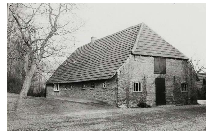
Boerderij Venstraat I. Op de foto uit 1980 is de kopgevel aangepast maar er zijn nog veel authentieke elementen aanwezig.
