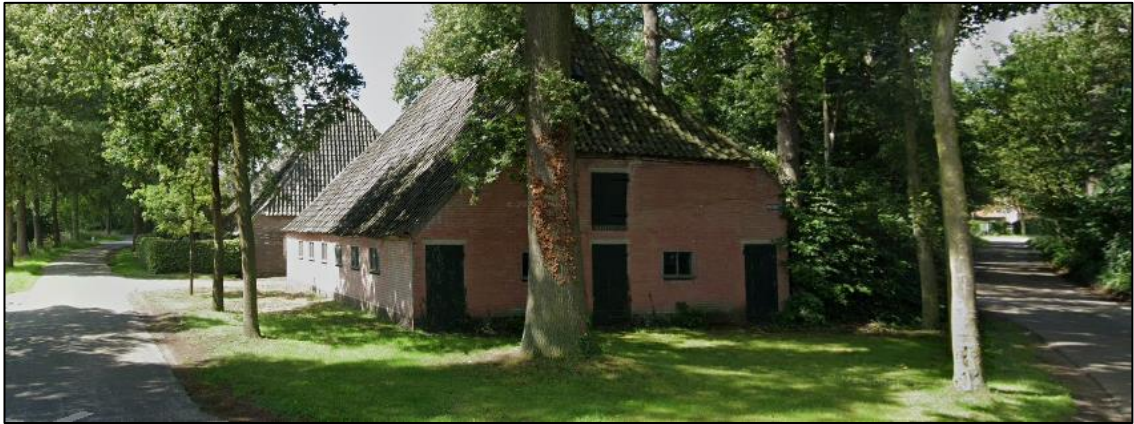
Figuur 10: Te verbouwen bijgebouw Venstraat 2
