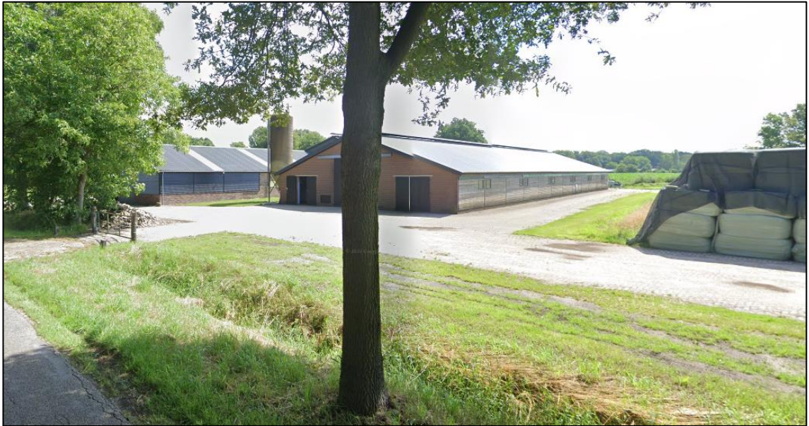
Figuur 8: Geitenstal Venstraat 1
