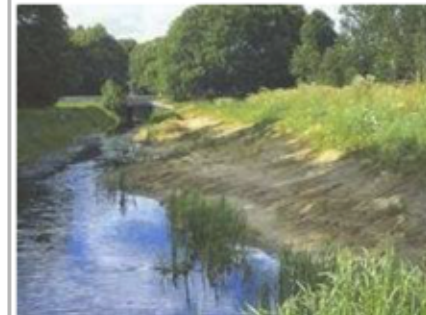
Waterloop met flauw talud
