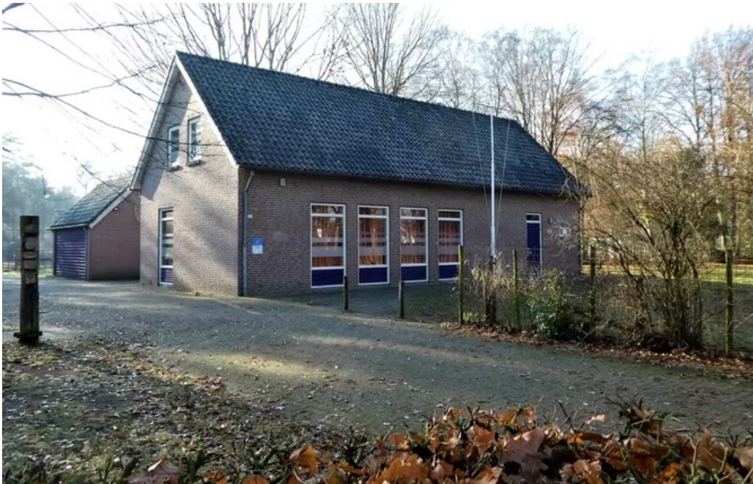
Figuur 25: Het gesloopte scouting gebouw in het plangebied (bron: https://www.ad.nl/boxtel/scoutinggebouw-petrus-donders-tegen-de-vlakte~a7aaddb7/161939495/ ).
