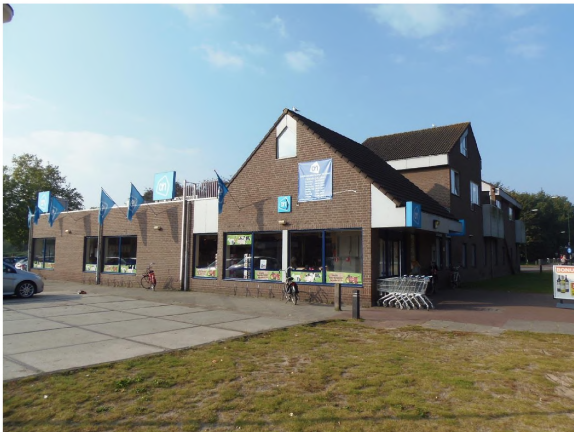
Figuur 8. Impressie gebouw 6: Albert-Heijn supermarkt.
