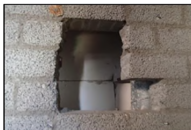
Figuur 16. Toegang tot spouwmuur.
