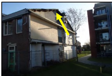
Figuur 13. Ruimte onder dakpannen voor huismus.
