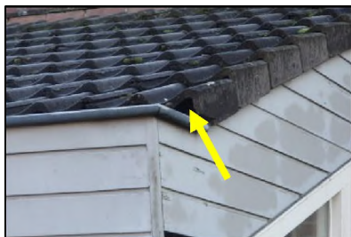
Figuur 12. Ruimte onder dakpannen voor huismus.
