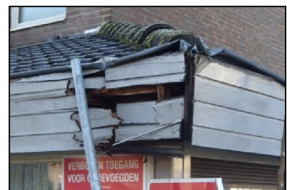
Figuur 17. Ruimte achter betimmering.
