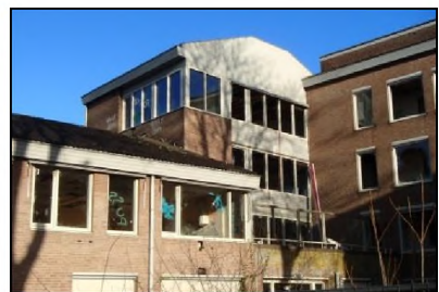
Figuur 8. Achteraanzicht vanuit het zuiden.
