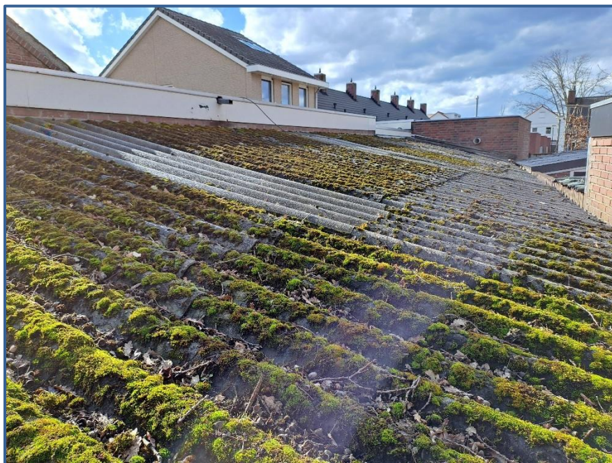
Dak van golfplaten aanbouw noordkant
