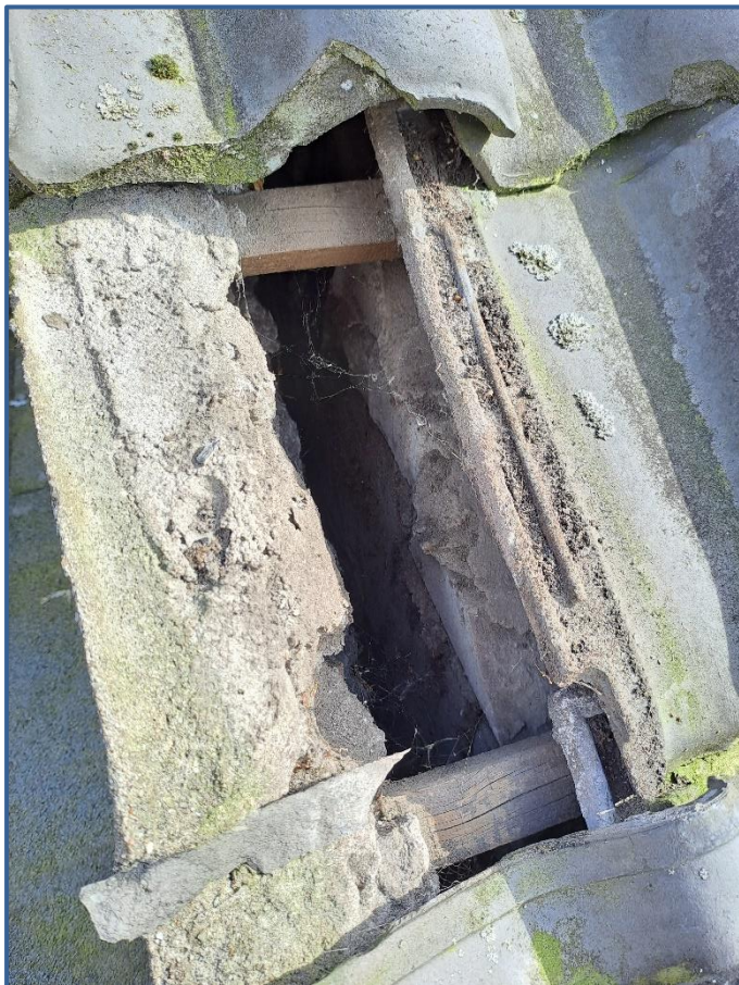
Ruimte onder dakpannen, spouwmuur zichtbaar
