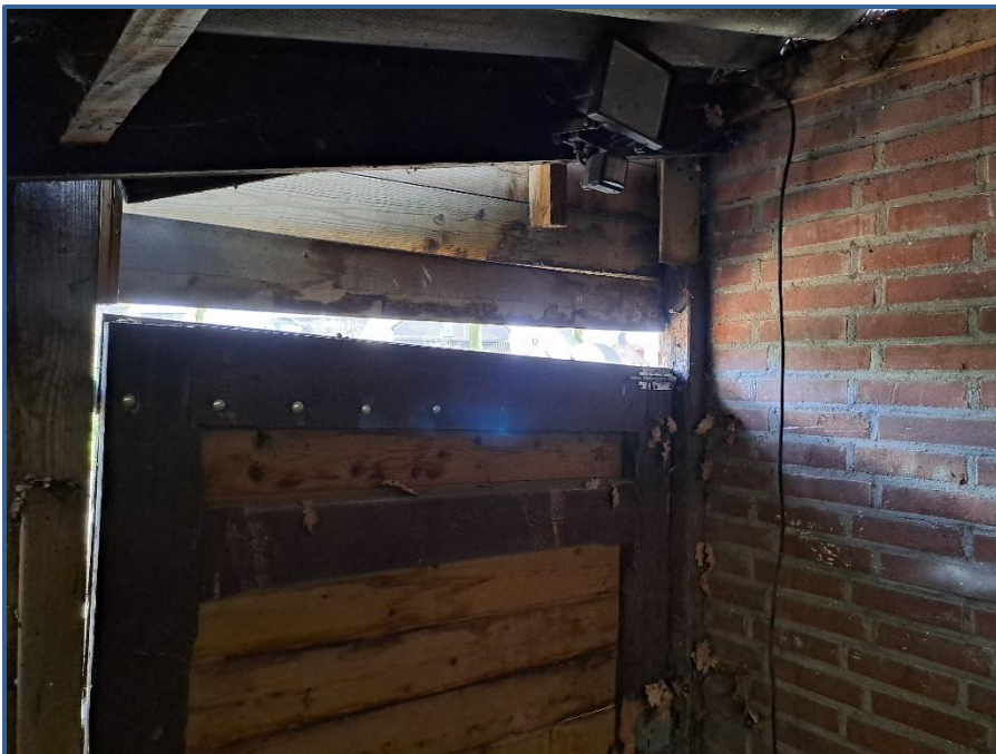
Opening boven deur aanbouw noordkant
