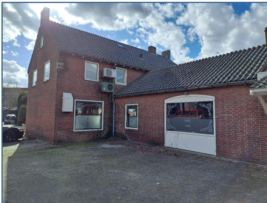
Buitenzijde bestaande bebouwing vanaf de noordoostkant
