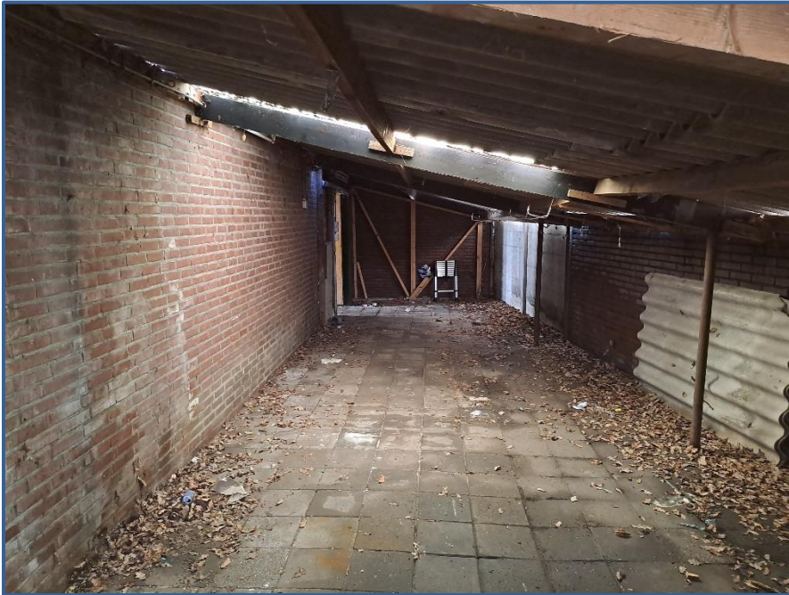
Binnenkant aanbouw noordkant
