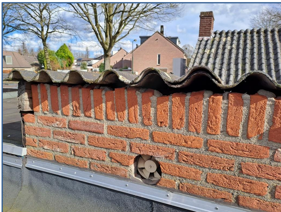
Openingen onder dakpannen vanaf de noordwestkant
