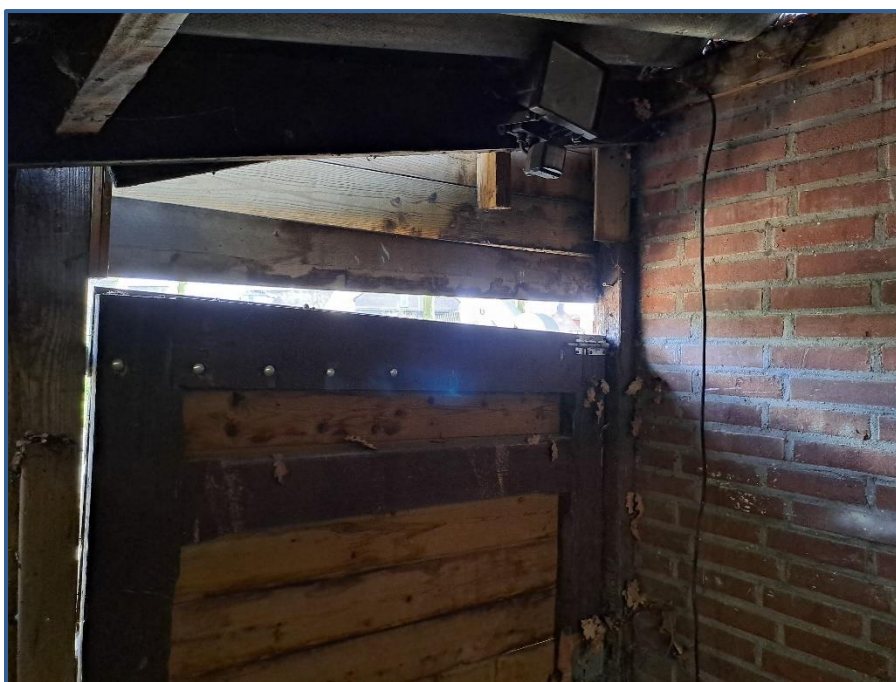
Opening boven deur aanbouw noordkant
