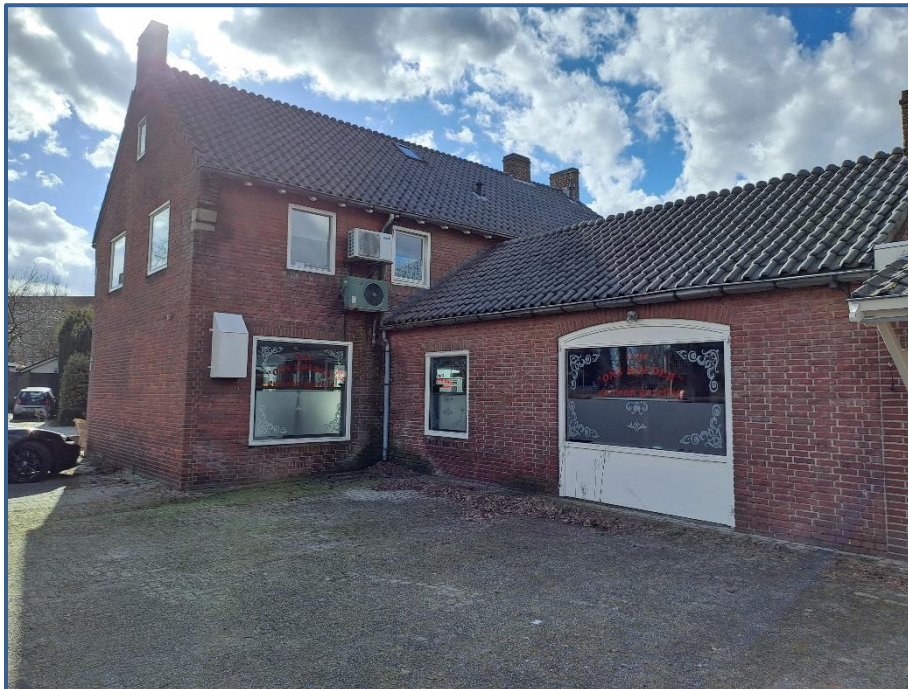
Buitenzijde bestaande bebouwing vanaf de noordoostkant
