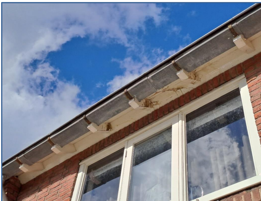
Onderkant dakgoot zuidkant
