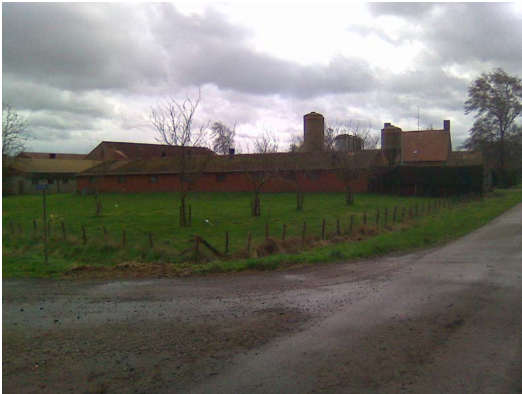
Foto 15 Zicht op bouwlocatie waar naast de bestaande sloot de extra waterberging gecreëerd kan worden .
