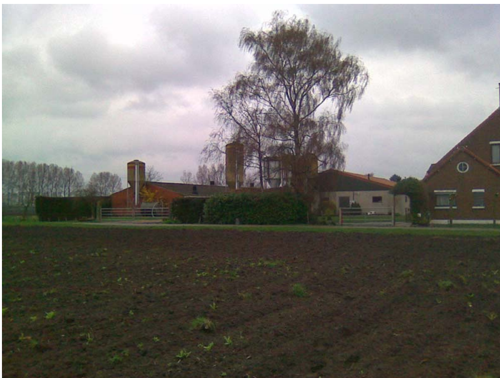
Foto 9 en 10 zicht op de stallen aan de westzijde.
