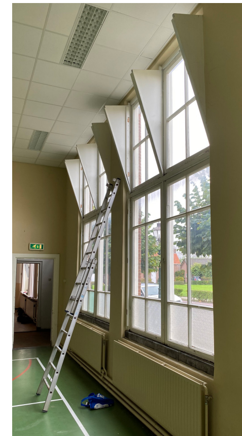
^ geen afwerking aan houten raam
