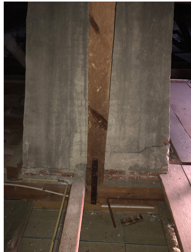
^ verbinding makelaar en trekker spant
