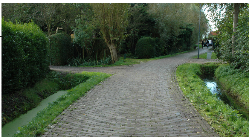
wegen: gebakken klinkers dikformaat, rood genuanceerd
