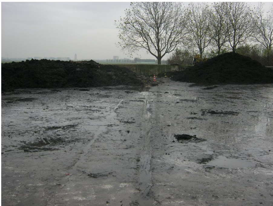
IMG_4430 Opslag vaste meststoffen gezien in zuidoostelijke richting. Centraal op de foto een dilatatie in de betonvloer. Ter plaatse van dilatatie zijn de monsterpunten 201 en 101. In het verlengde van de dilatatie is achter de keermuur in de achtergrond op de foto, de locatie van peilbuis 36 gelegen.
