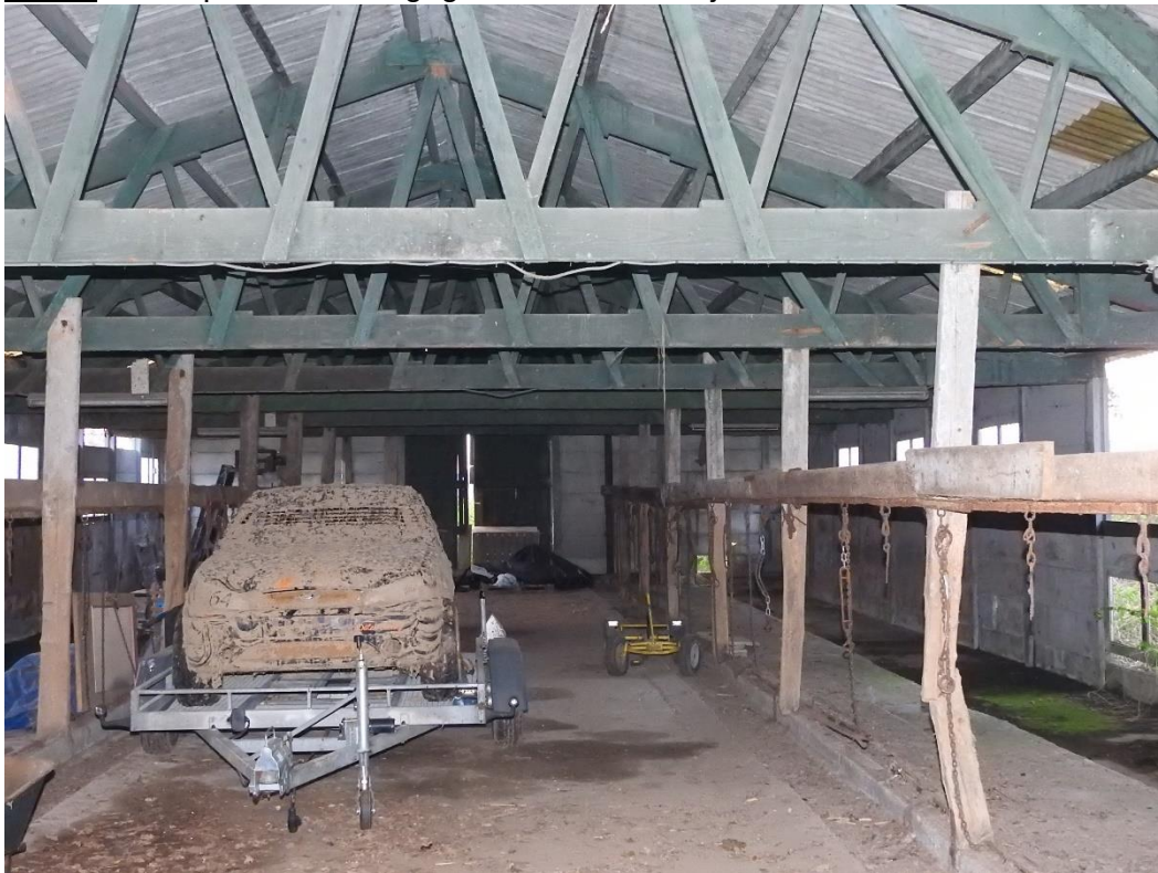
Foto 2. Te slopen bebouwing, gebouw 1 binnenzijde.
