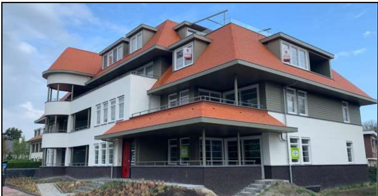
Figuur 4: Appartementencomplex Boulevard de Wielingen 14 Cadzand-Bad
