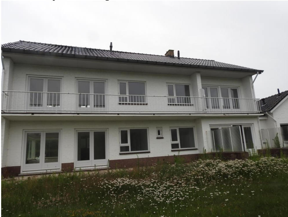
Foto 1. Te slopen bebouwing.
