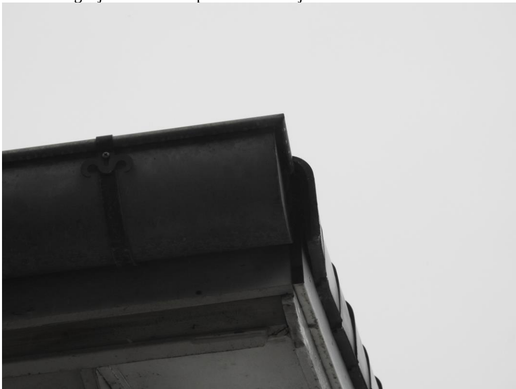
Foto 2. Mogelijkheden achter pannen en daklijsten.
